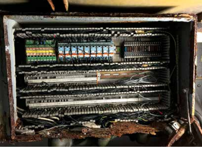
Vorher: ein durchgerosteter Kasten, in der die Elektronik untergebracht ist.
