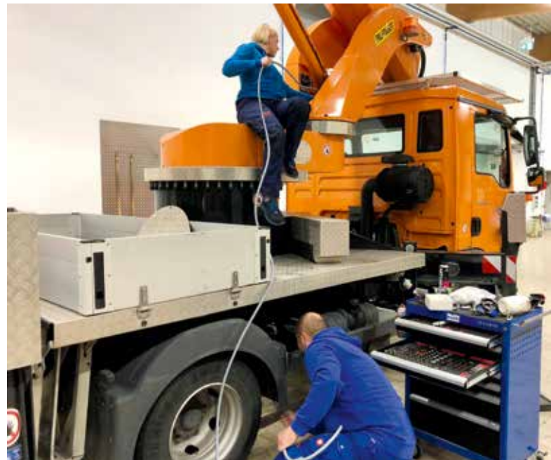
Teamwork beim Austausch eines gebrochenen Kabels an einem Kommunalgerät.
