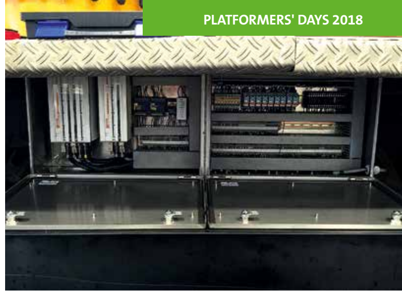
Nachher: nach der Reparatur erstrahlt der E-Kasten in neuem Glanz.
