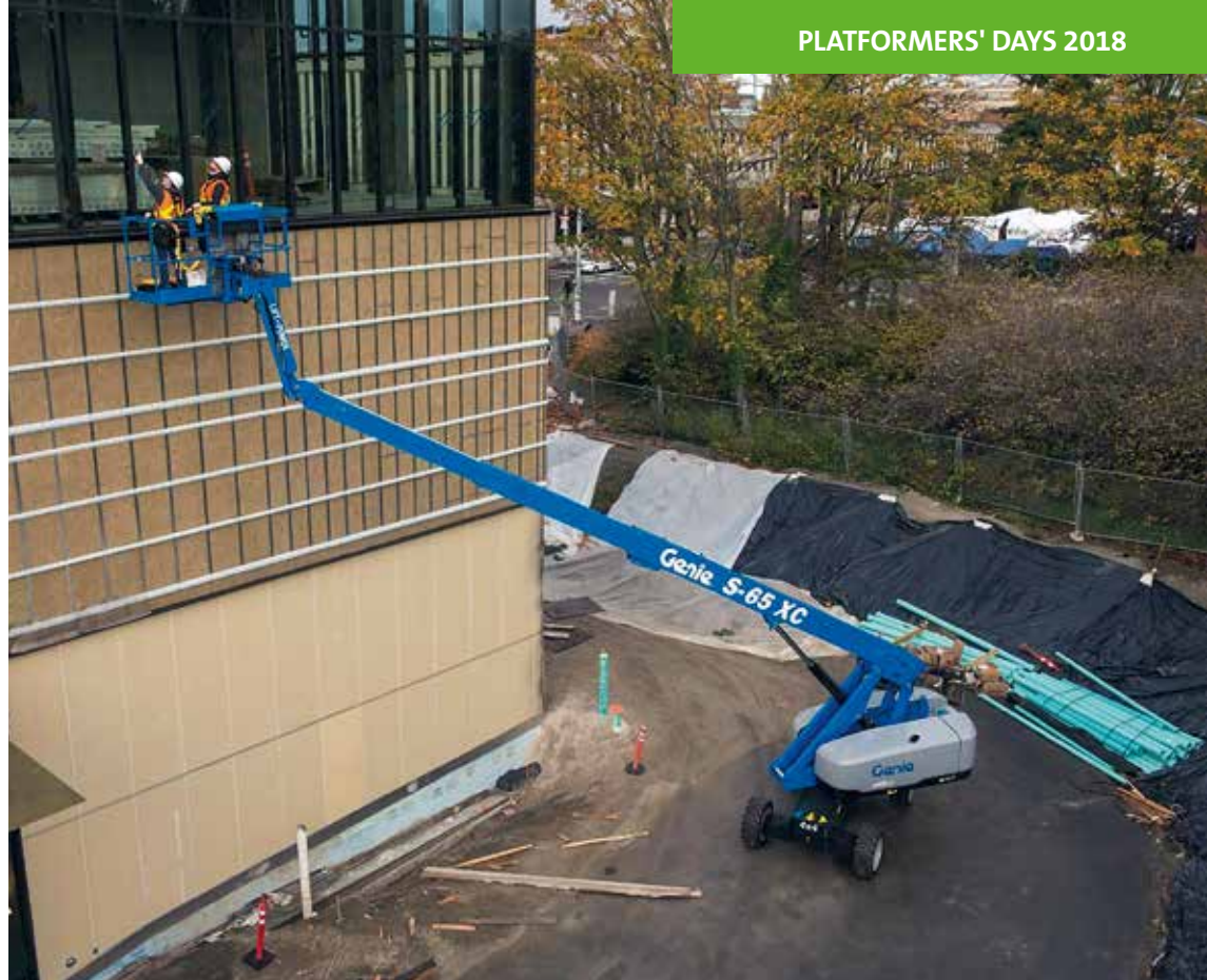
Die S-65 XC im Einsatz an einer Fassade.
