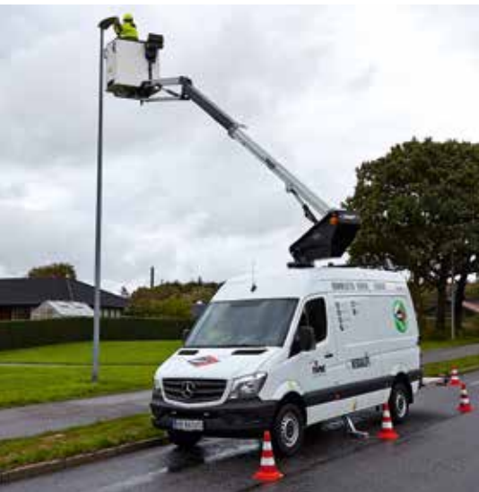
Insbesondere im Innenstadtbereich von Großstädten können solche Arbeiten an Straßenbeleuchtungen problemlos im Elektrobetrieb durchgeführt werden.
