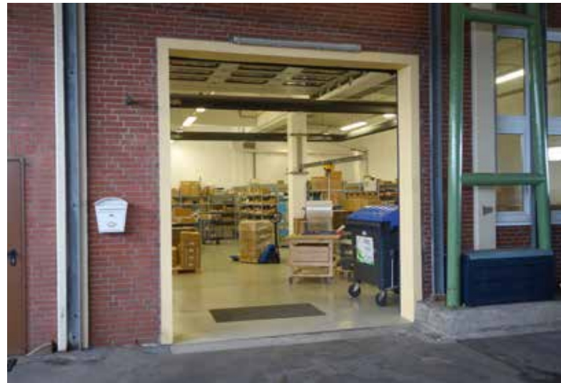
Im überdachte Anlieferungsbereich können auch Lkw mit 4 m Höhe problemlos Paletten anliefern, die dann einfach per Hubwagen durchs Rolltor gefahren werden können. BM-Bild
