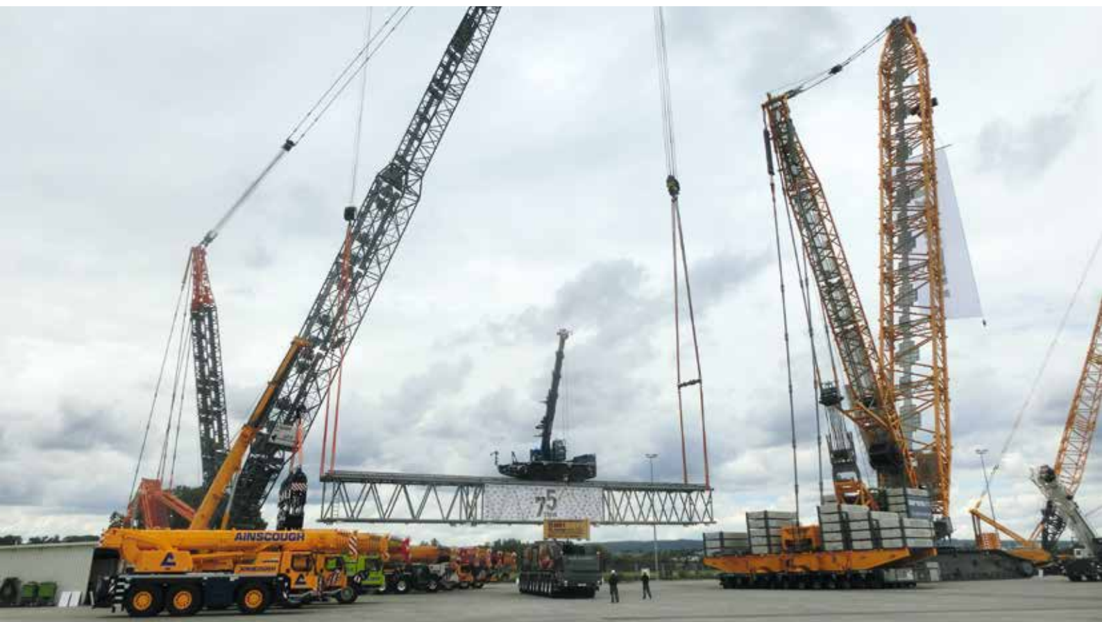
Während des Tandemhubs verfahrbar, teleskopierbar und hubbereit, der LTM 1060-3.1.
