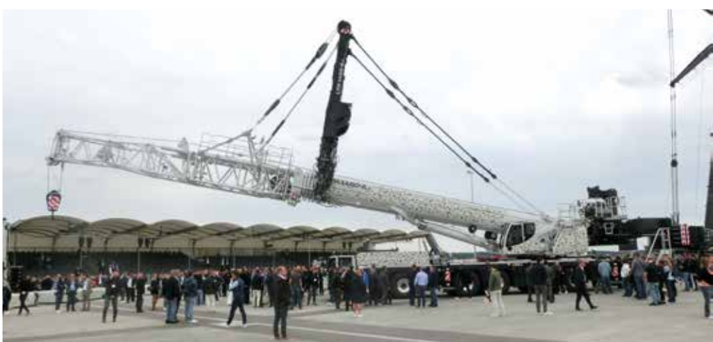
Der neue 6-Achser wuppt dank Gittermastspitze und Y-Abspannung 400 Tonnen.
