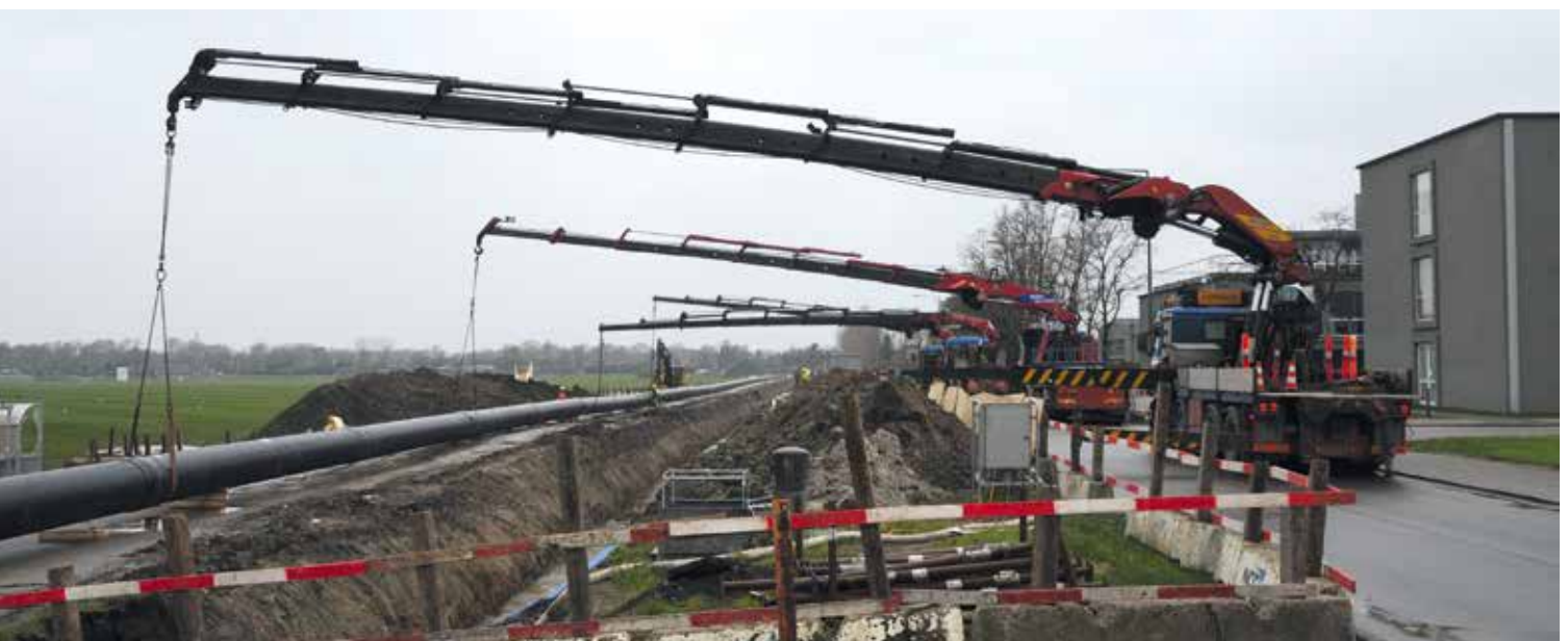
Bei dem Einsatz dabei waren zwei Fassi F1500AXP.28, ein Effer 1550S8 und ein Effer 1750LS8.
