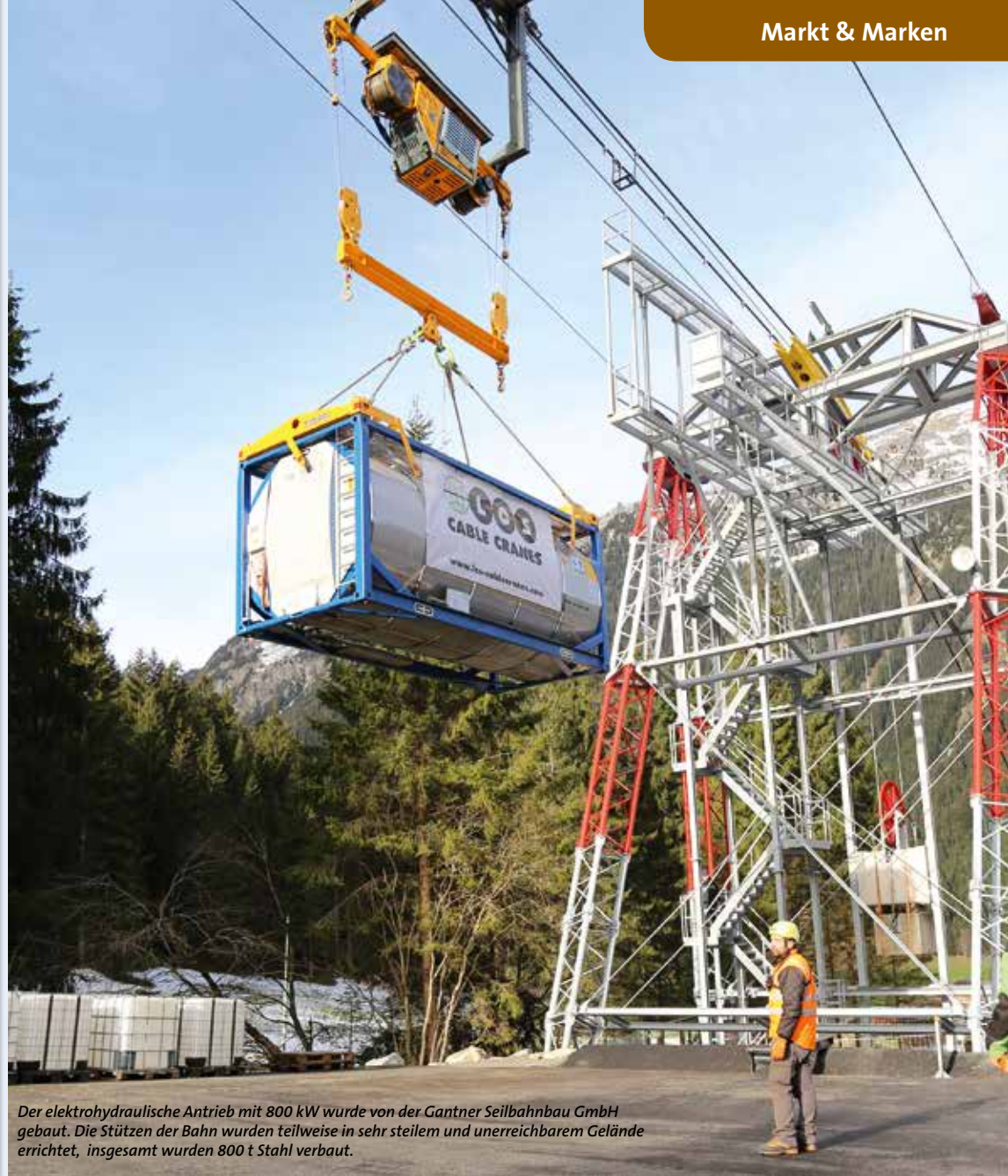
20 t Tragkraft bietet der Seilkran GC200 mit 100 PS und Doppelhubwerk.
