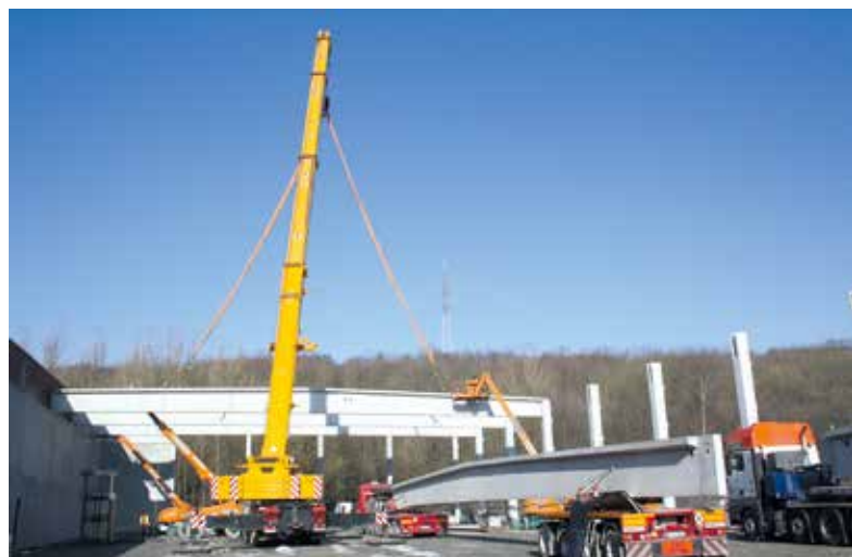
Vom 10.-11.06. 2015 findet im HDT in Essen die Fachtagung „Fahrzeugkrane“ statt. Das Bild zeigt einen Kraneinsatz im Auftrag des Soester Hochbauspezialisten Lehde. Das Unternehmen war von der M. Busch GmbH & Co. KG mit dem Bau einer 2500 Quadratmeter großen Versand- und Lagerhalle beauftragt worden. Bild: Lehde GmbH/Prünke & Kollegen
