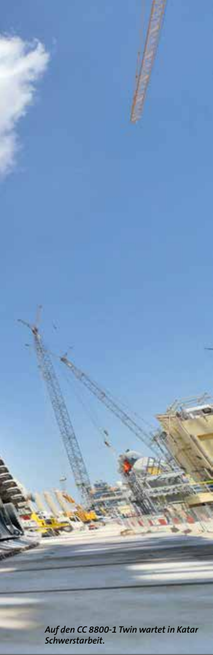
Nur in der Ausstattung als TWIN konnte der CC 8800-1 die je 1.300 t schweren Absorber heben.
