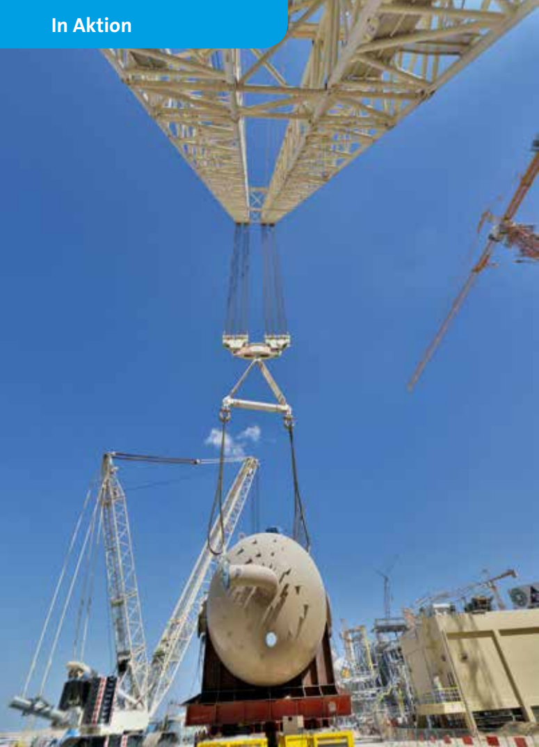
Erst wurden die Absorber angehoben ...
