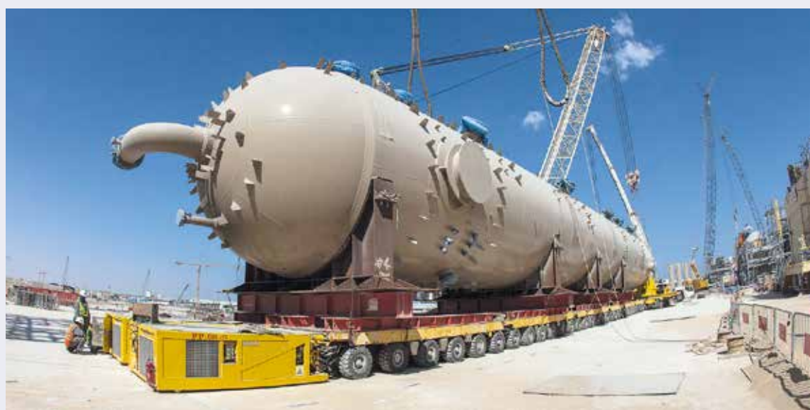
Noch ruht der Stahlkoloss auf den SPMTs.
