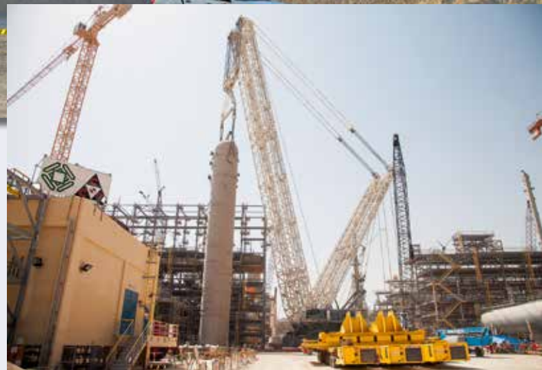
Nach einer Schwenkbewegung um 90 Grad wurde der AGR schließlich auf dem dafür vorgesehenen Fundament in seine endgültige Position gebracht.
