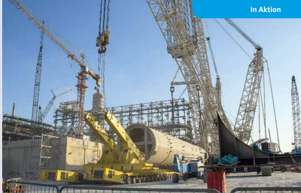
Nur in der Ausstattung als TWIN konnte der CC 8800-1 die je 1.300 t schweren Absorber heben.
