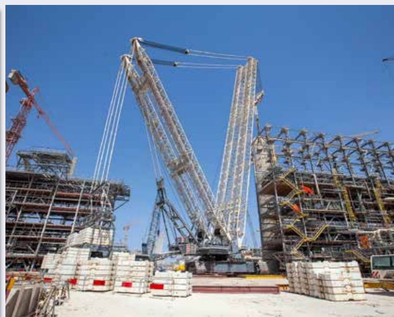
... muss viel Ballast aufgelegt werden.
