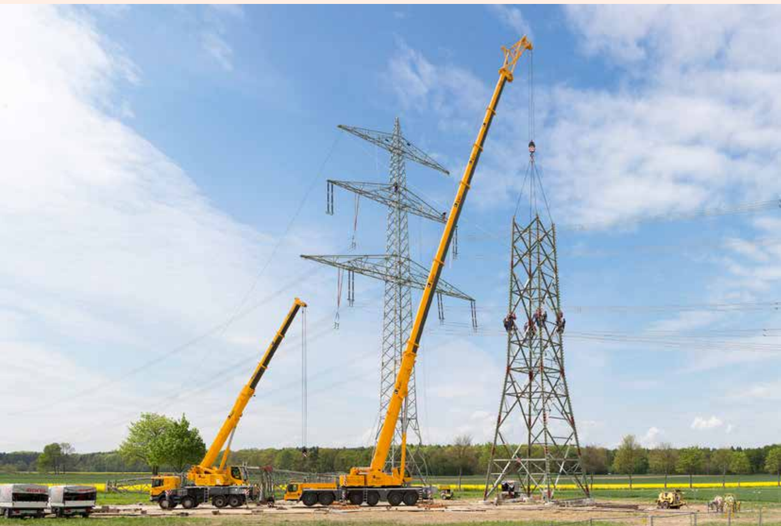
Zur Montage der 12 t schweren oberen Traverse ist der LTM 1300-6.2 mit einer 5,5 m langen Montagespitze ausgerüstet und auf 63,3 m Auslegerlänge teleskopiert.
