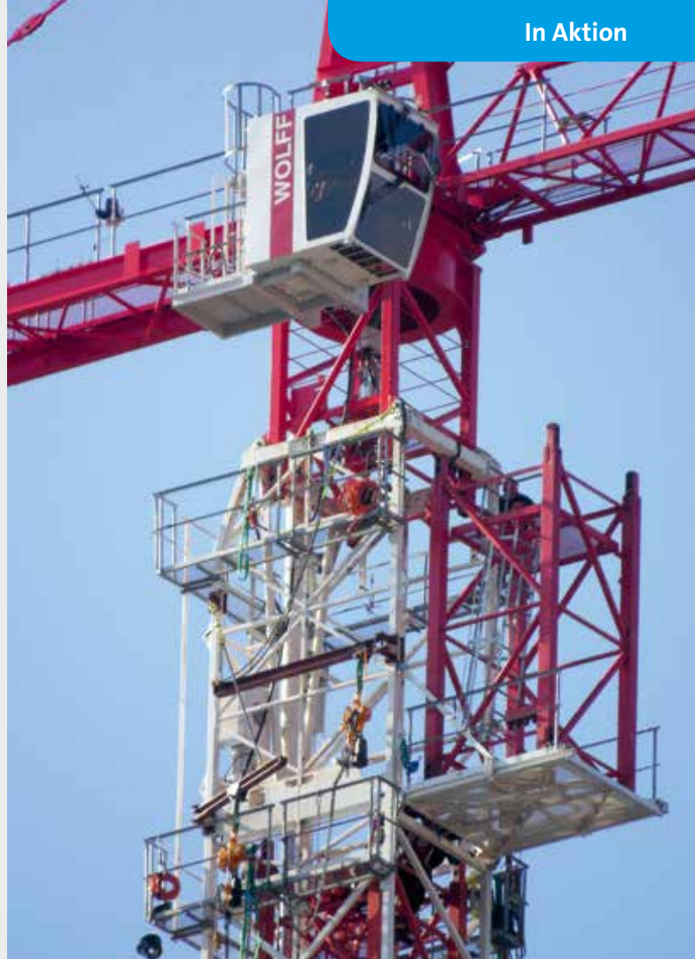
Die Laufkatzkrane wurden mit steigender Gebäudehöhe regelmäßig geklettert. Kranoberteil und Turm sind dabei phasenweise nur durch das hydraulisch arbeitende Kletterwerk verbunden. Ein einzelner Klettervorgang dauert rund eine Stunde.
