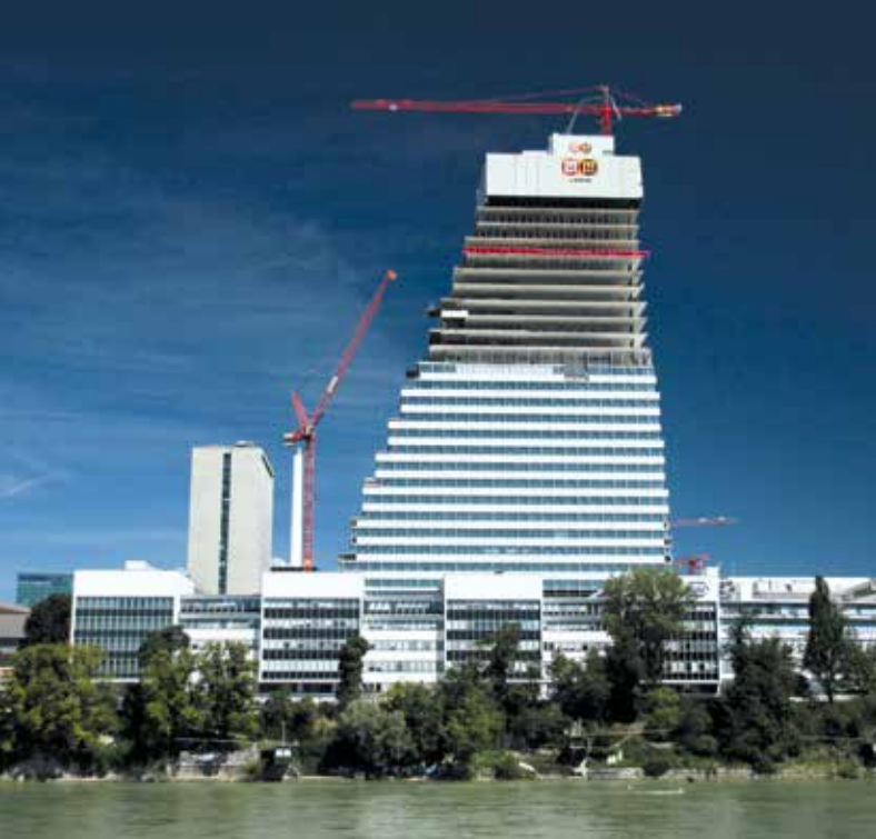
Wegen der ungewöhnlichen Gebäudeform wurde der zuerst eingesetzte Wolff 6023.8 ab einer gewissen Höhe gegen den Wipper Wolff 180 B ausgetauscht. Bild: Rainer Brombach
