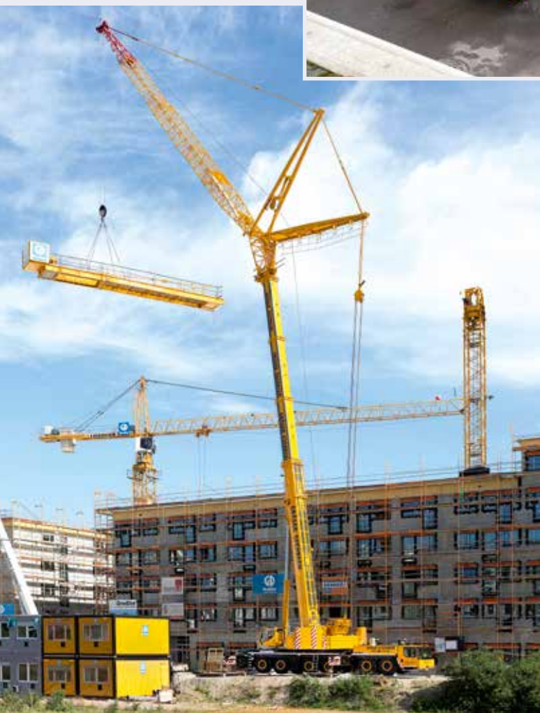
Das Kranunternehmen Gräser-Eschbach setzt den LTM 1300-6.2 vielfach bei der Montage von Turmdrehkränen ein.
