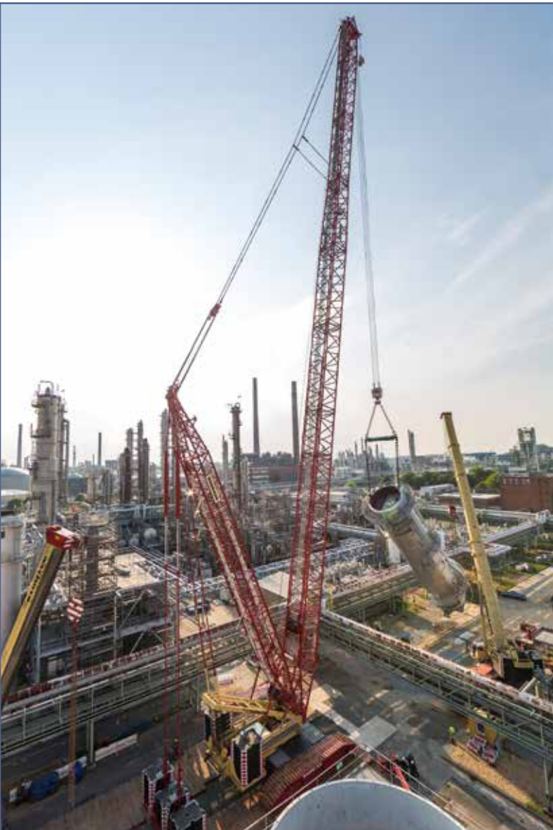
Für die Installation der Kolonnenteile im Werk setzte Baumann einen LTM 1500-8.1 und einen Terex SL 3800 ein.
