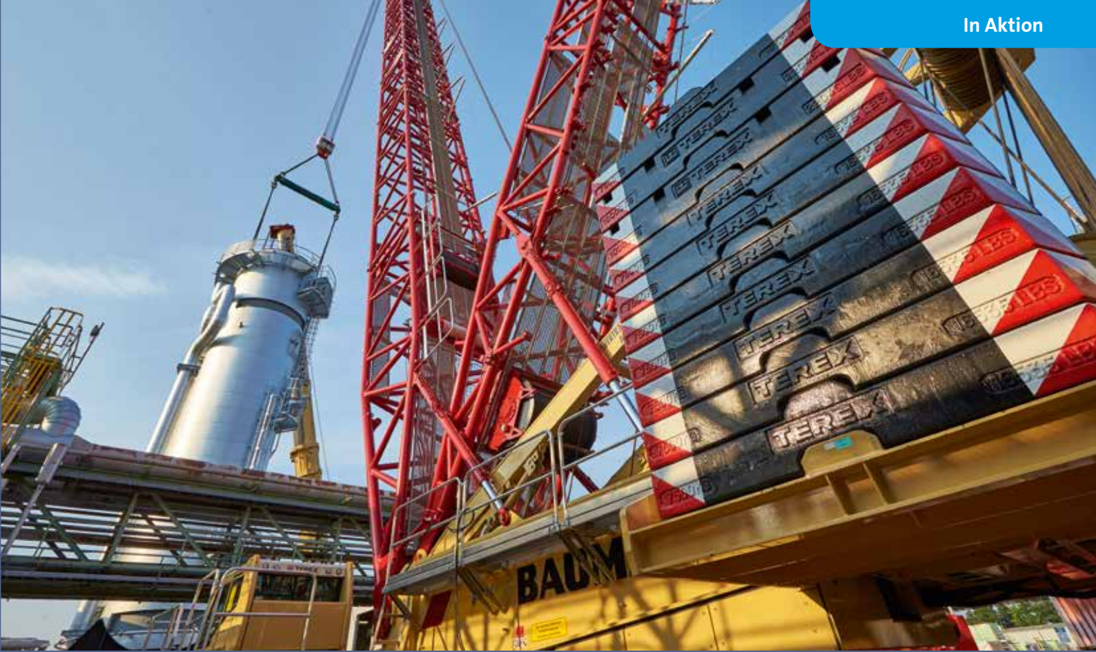
Für die Installation der Kolonnenteile im Werk setzte Baumann einen LTM 1500-8.1 und einen Terex SL 3800 ein.
