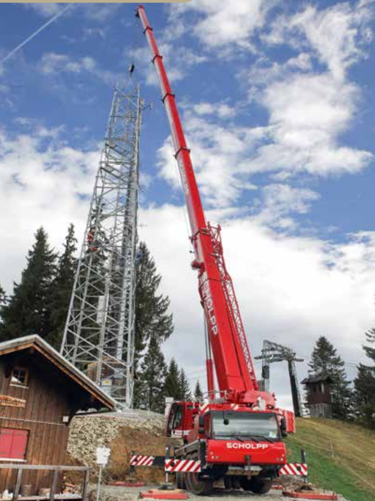
Einen seiner ersten Kraneinsätze meisterte der neue LTM 1100-4.2 in den Allgäuer Alpen. Das Team der Scholpp Kran & Transport GmbH hatte in Balderschwang einen Funkmast für BOS-Technik zu errichten. Für diesen Einsatz musste der 4-achsige Mobilkran steile Schotterwege und enge Kurven bis auf 1.500 Meter Meereshöhe erklimmen.
