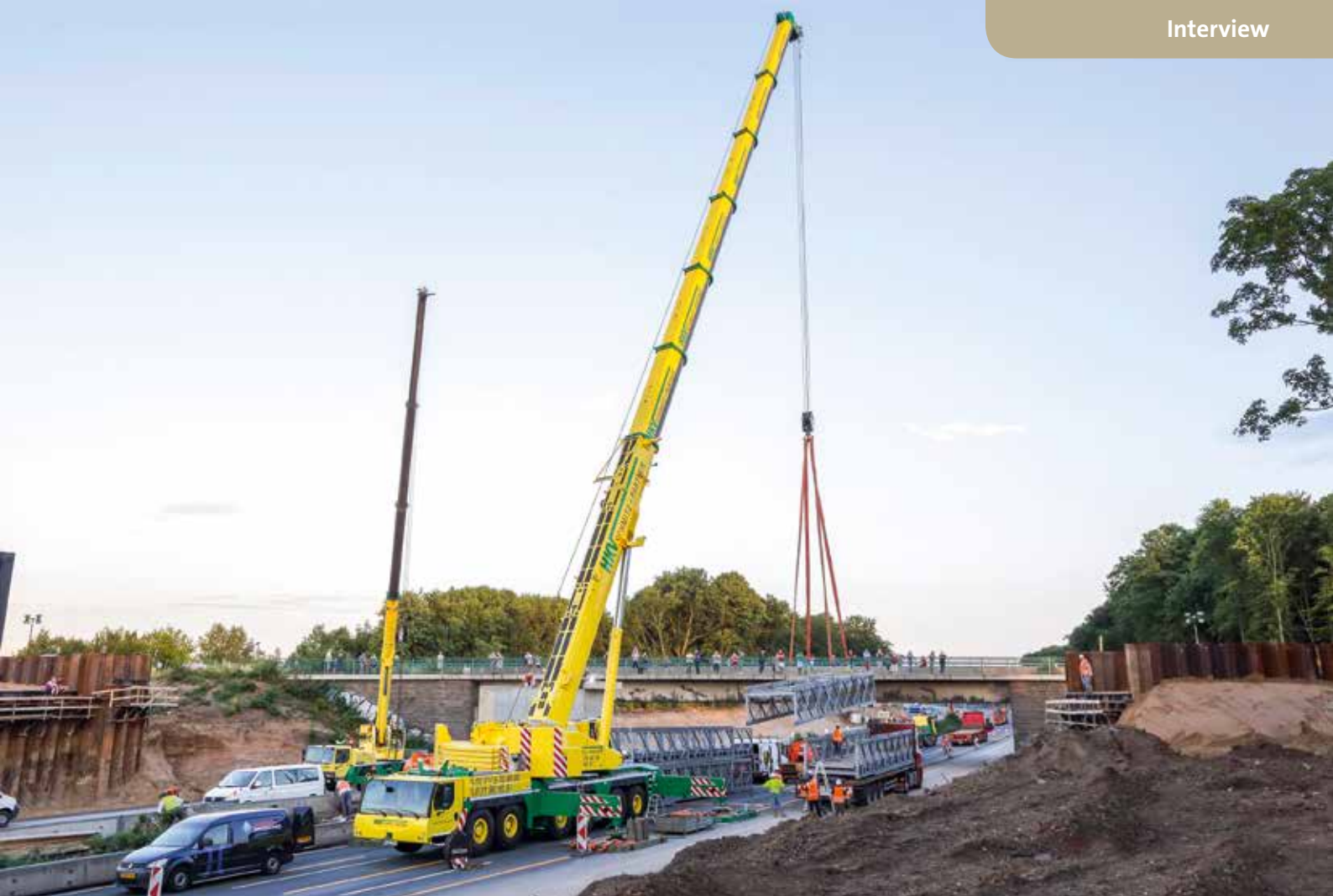
Der Autobahnabschnitt der A3 zwischen Köln-Mülheim und Leverkusen wird auf acht Fahrstreifen ausgebaut. Da die alten Brücken, die über die Autobahn führen, für den Ausbau nicht lang genug sind, werden neue Brücken benötigt. Für die Übergangszeit während der Bauarbeiten montierte ein Liebherr-Mobilkran LTM 1300-6.2 von HKV Schmitz + Partner eine Behelfsbrücke.
