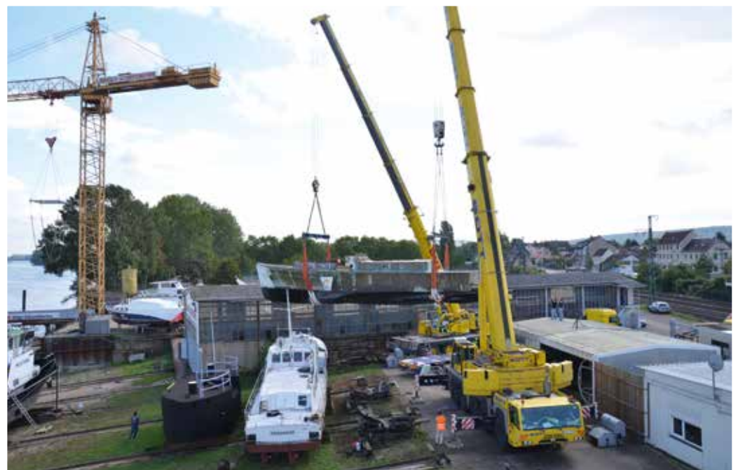
Terex AC 200 und ein GROVE GMK 4100 heben das Schiff in der Werft auf einen Tieflader.
