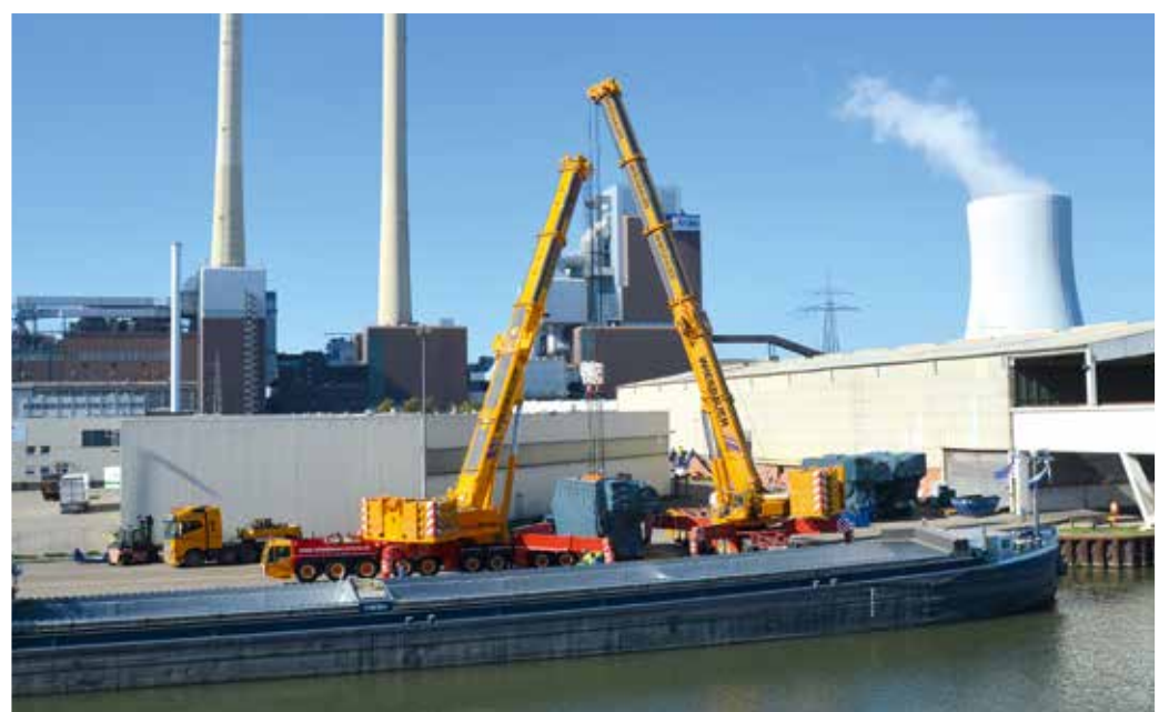
Einsatz an der Kaimauer: Terex AC 500-2 und AC 700.
