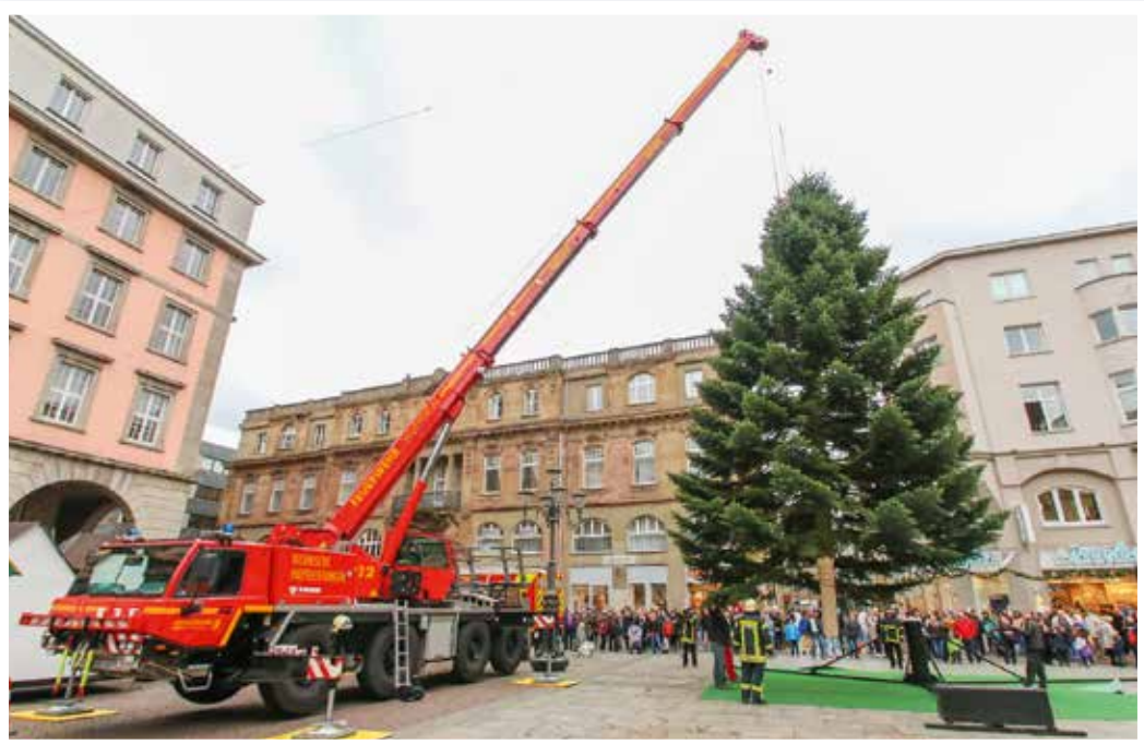
Der Weihnachtsbaum in Wuppertal wird mit einem Tadano Faun-Feuerwehrkran aufgestellt.
