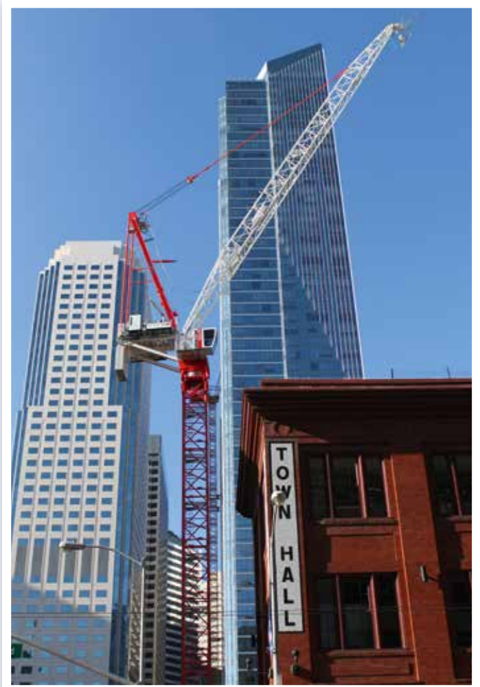
Mit einer Turmhöhe von 233 m und 50 m Ausleger ist der Wolff 700 B in San Francisco im Einsatz. Der Wipper punktet hier mit seinem kompakten, nur 7,7 m langen Ausleger.
