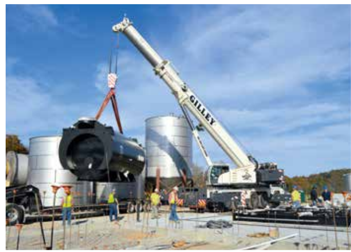
Mit 70,2 t Gegengewicht kommt der Terex Explorer 5800 in der Brennerei von Jack Daniel's zum Einsatz, um die 6,1 m hohen und 7,6 m langen Kessel sowie ihre 4,5 t schweren Sockel zu positionieren.
