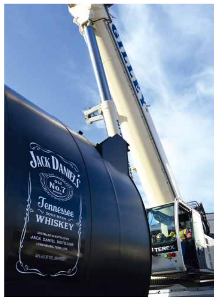
Mit 70,2 t Gegengewicht kommt der Terex Explorer 5800 in der Brennerei von Jack Daniel's zum Einsatz, um die 6,1 m hohen und 7,6 m langen Kessel sowie ihre 4,5 t schweren Sockel zu positionieren.
