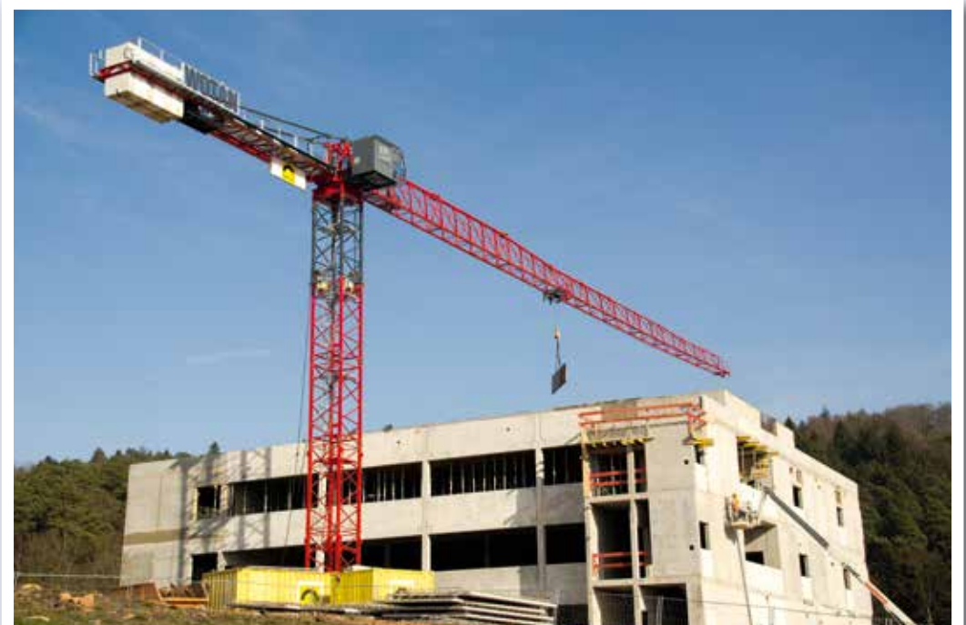
Betonfertigteil am Haken von BBL 7024 Wotan. Bild: HSMS
