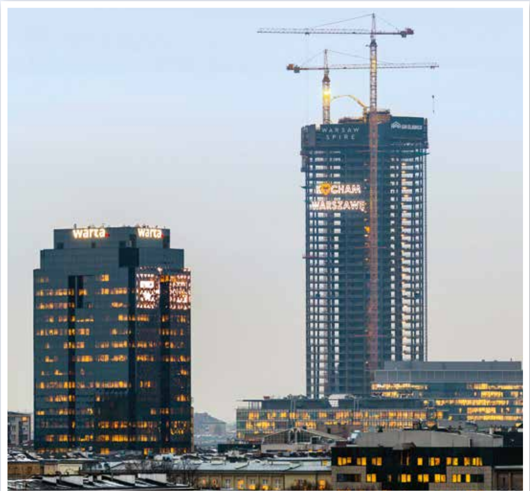
Zwei Liebherr-Turmdrehkrane 280 EC-H für Polens höchstes Gebäude. Mit nur vier Abspannungen erreichen sie ihre Endhakenhöhe von über 220 m.
