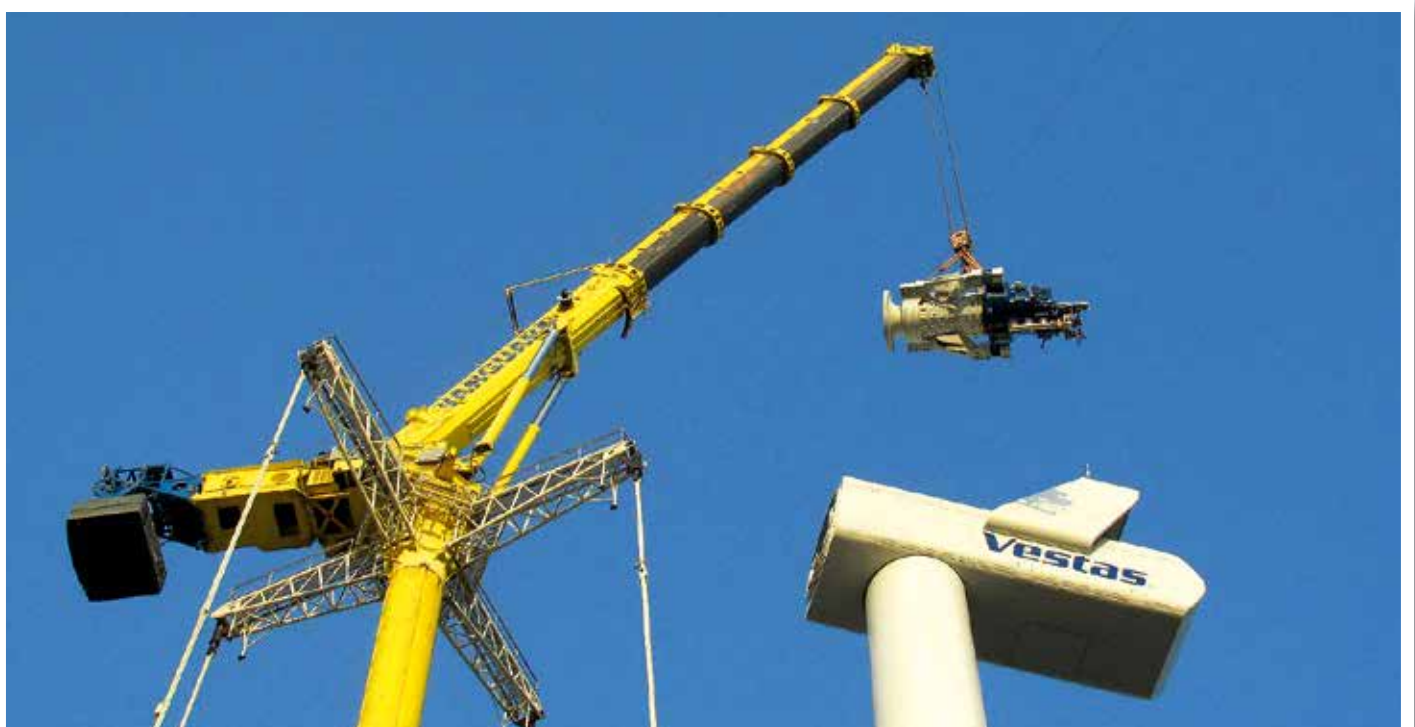
Der Grove GTK1100 im Einsatz in einem Windpark in Südafrika.
