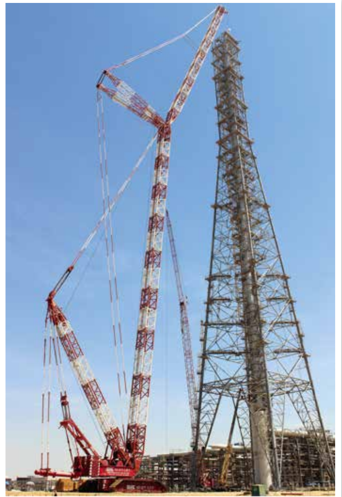
Auf eine Höhe von 200 m bringt es die Hochfackel, die der CC 8800-1 montiert.
