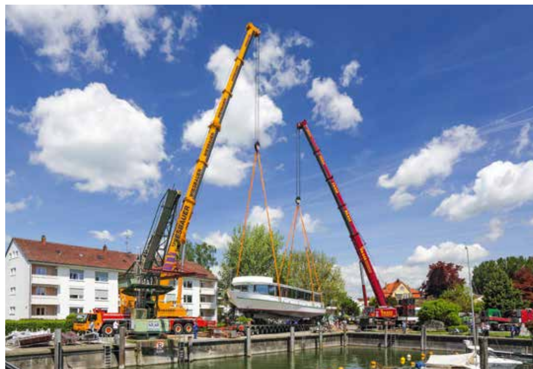
Im Tandemhub setzen ein LTM 1350-6.1 und ein LTM 1400-7.1 den 100 t schweren Schiffsrumpf ins Wasser.
