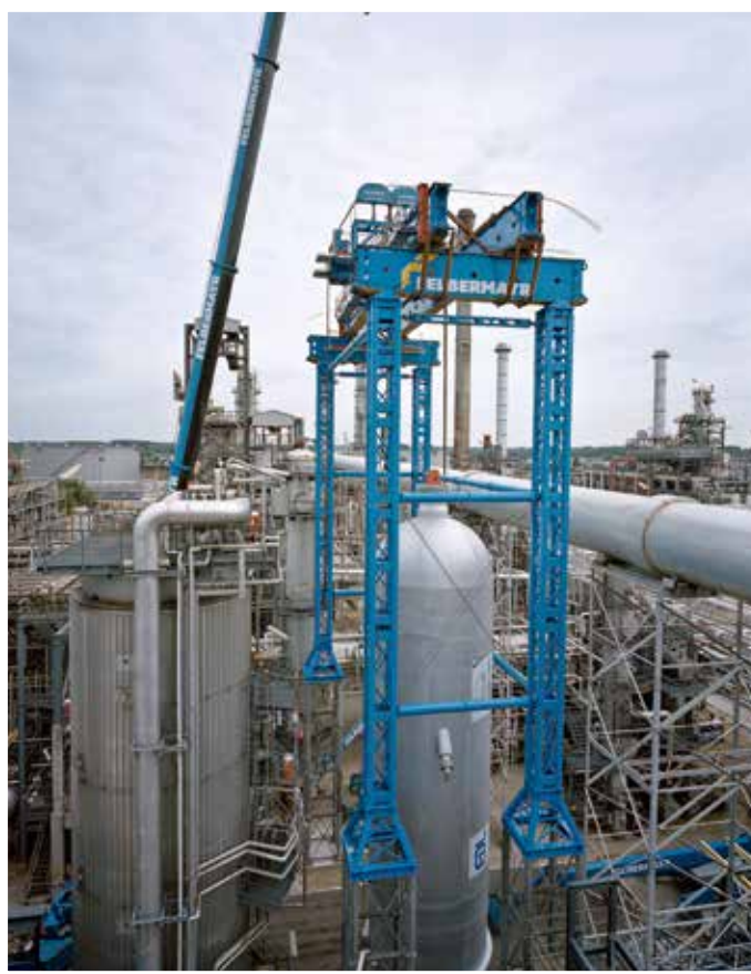
Einbringen der Kolonne auf das Fundament per Kippvorrichtung und Towerlift.
