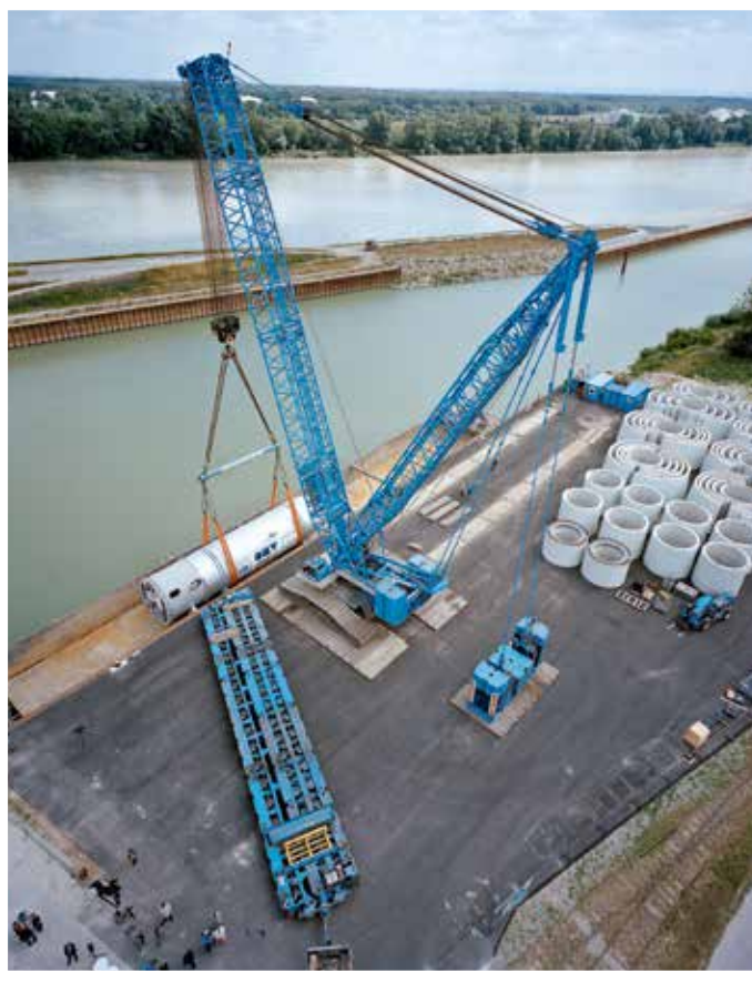
Ein Liebherr LR 1600 entlädt die Kolonne im Alberner Hafen in Wien.
