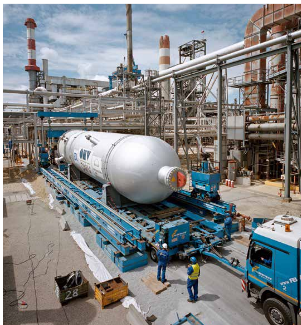
Nur per Verschubsystem konnte die Kolonne die Rohrleitung passieren.
