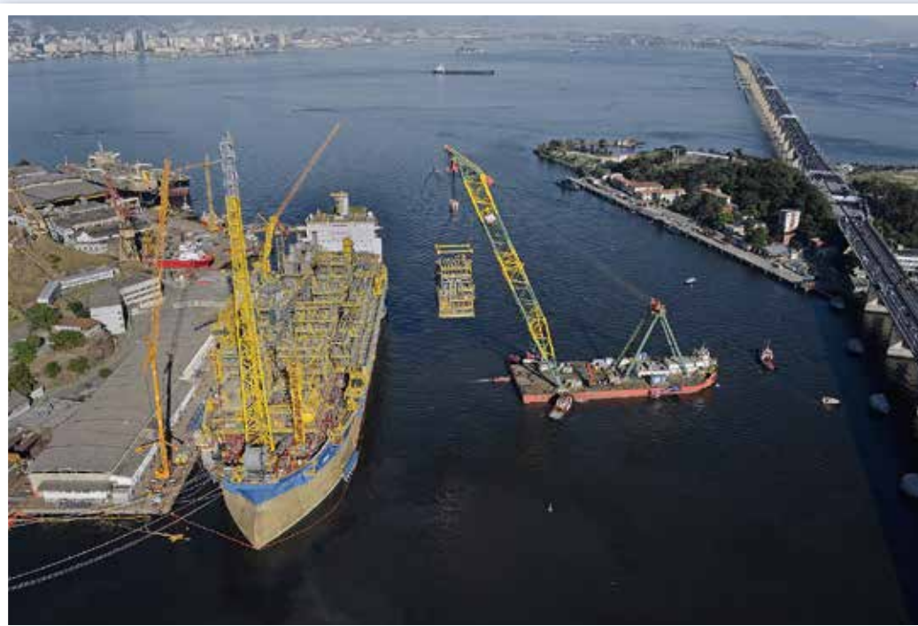
Schwimmkran „Pelicano“ beim Heben der bis zu 1.580 t schweren Module.
