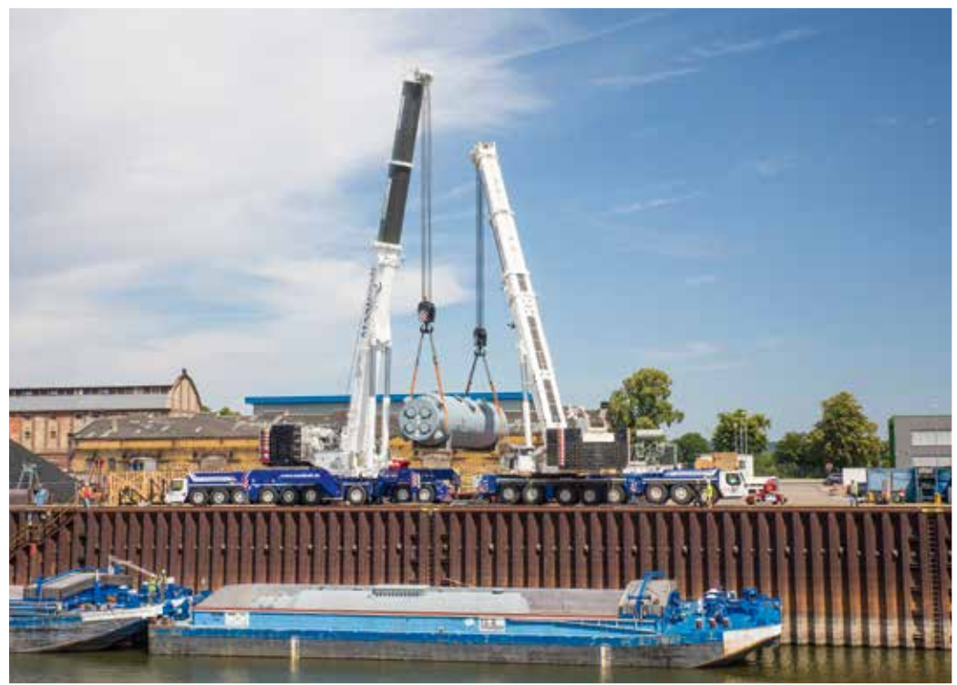
Anspruchsvolle Aufgabe: nach dem Abheben der Last von Tieflader, muss sie im Tandemhub zwischen den beiden Liebherr-Mobilkränen durchgeführt werden ...
