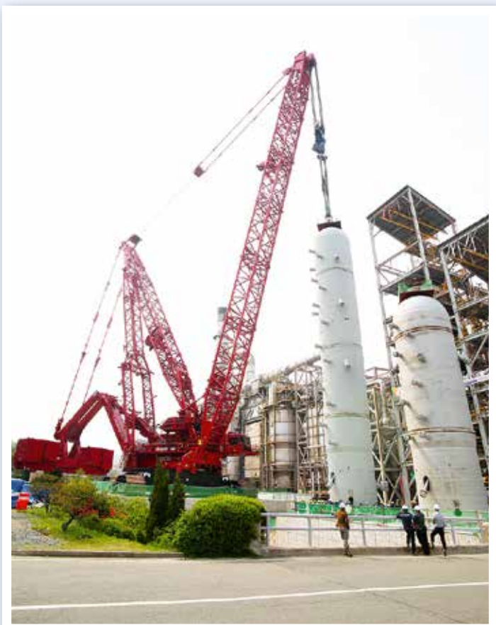
Auf dem Foto gut zu erkennen ist das Gegengewichtssystem mit variabler Position (VPC). Es verringert die Standfläche des Krans und reduziert Bodenvorbereitungen.
