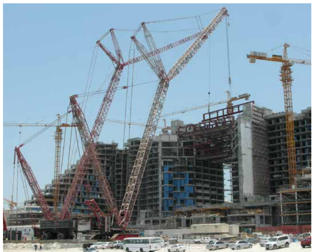
Liebherr LR 1600 und einen Terex CC8800 arbeiten im Tandem an der Präsidentensuite des Viceroy.
