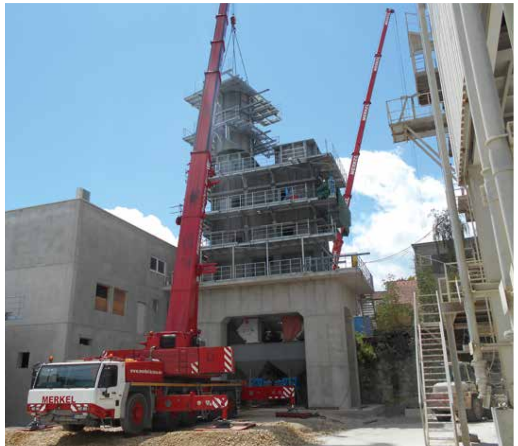
Der Tadano Faun ATF 220G-5 bei der Montage eines Kalkschaftefens.
