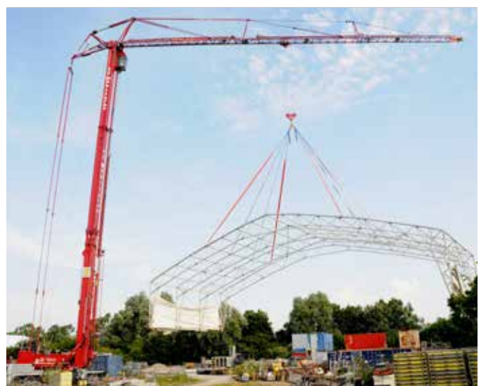
Der Spierings SK2400-AT7 ist jetzt bei dem dänischen Betreiber TT-Mobilkran im Einsatz. Bild: Frank Steckemetz.
