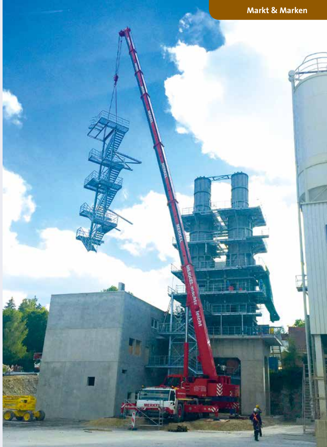
Der ATF 220G-5 von Merkel Autokrane beim Einheben eines Treppenteils.
