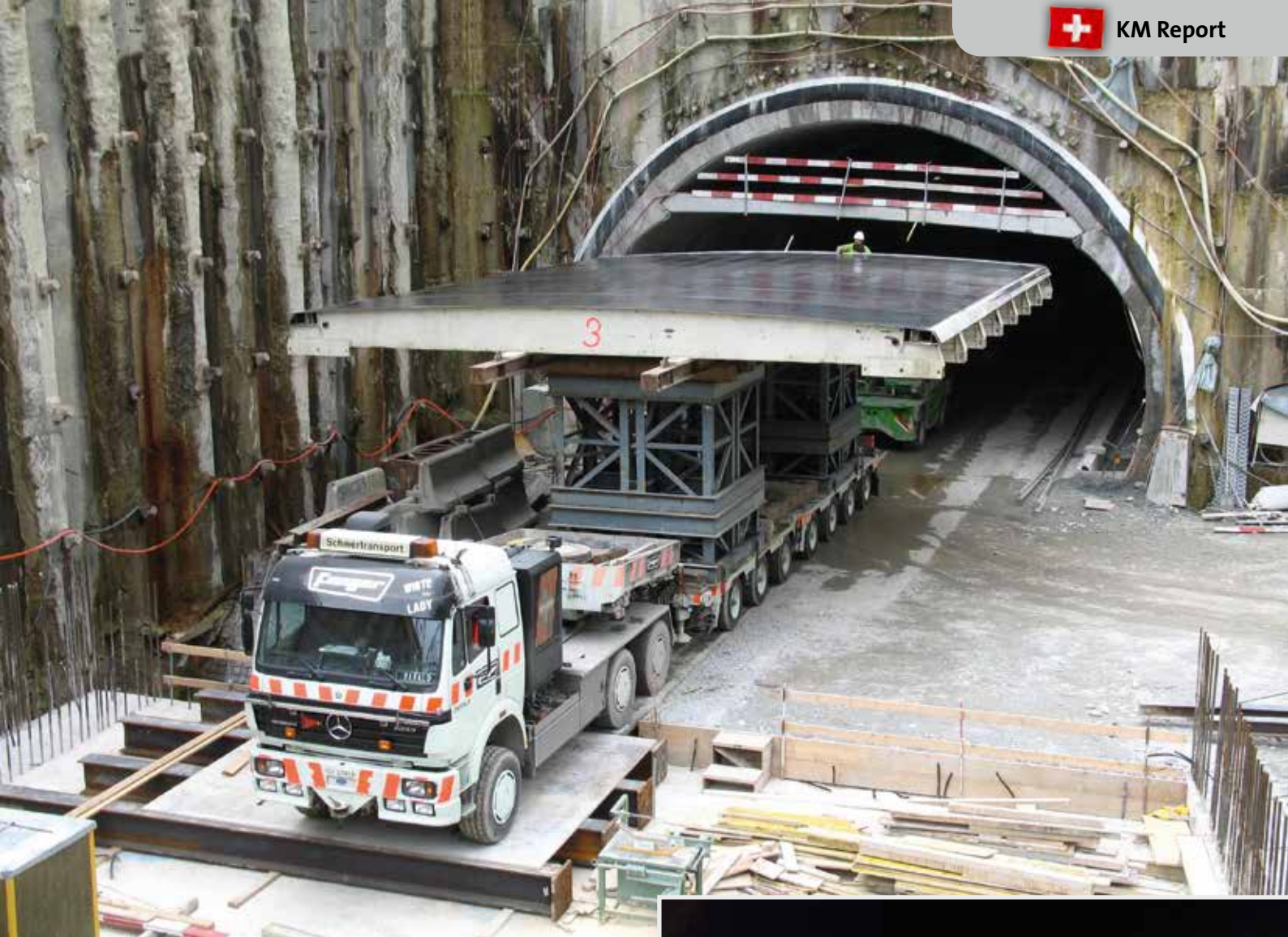
Den Tunnelbau beherrschen die Schweizer weltmeisterlich. Im Jahr 2016 wird mit dem Gotthardt-Basistunnel der längste Eisenbahntunnel der Welt eröffnet.
