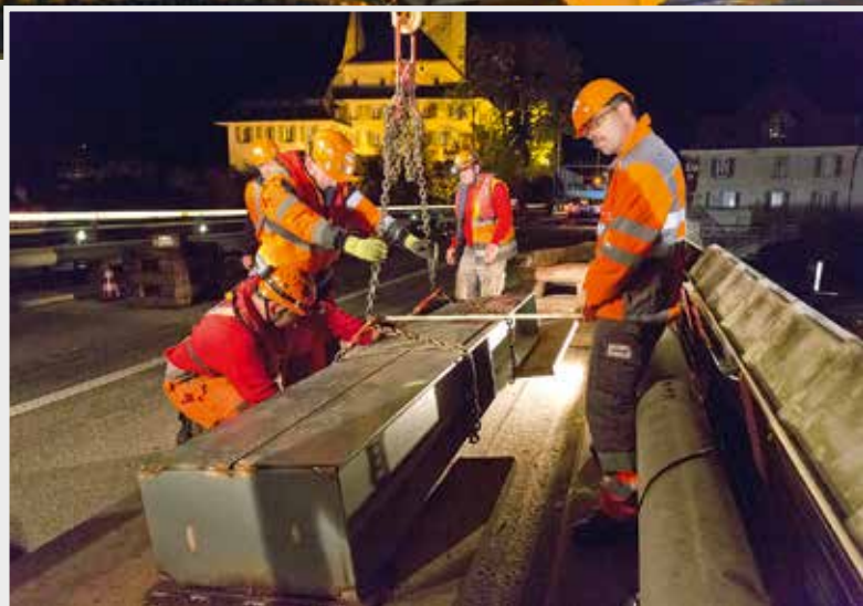
Eigens angefertigt: Spezielle Lastverteiler für die Kranabstützungen mussten zentimetergenau positioniert werden.
