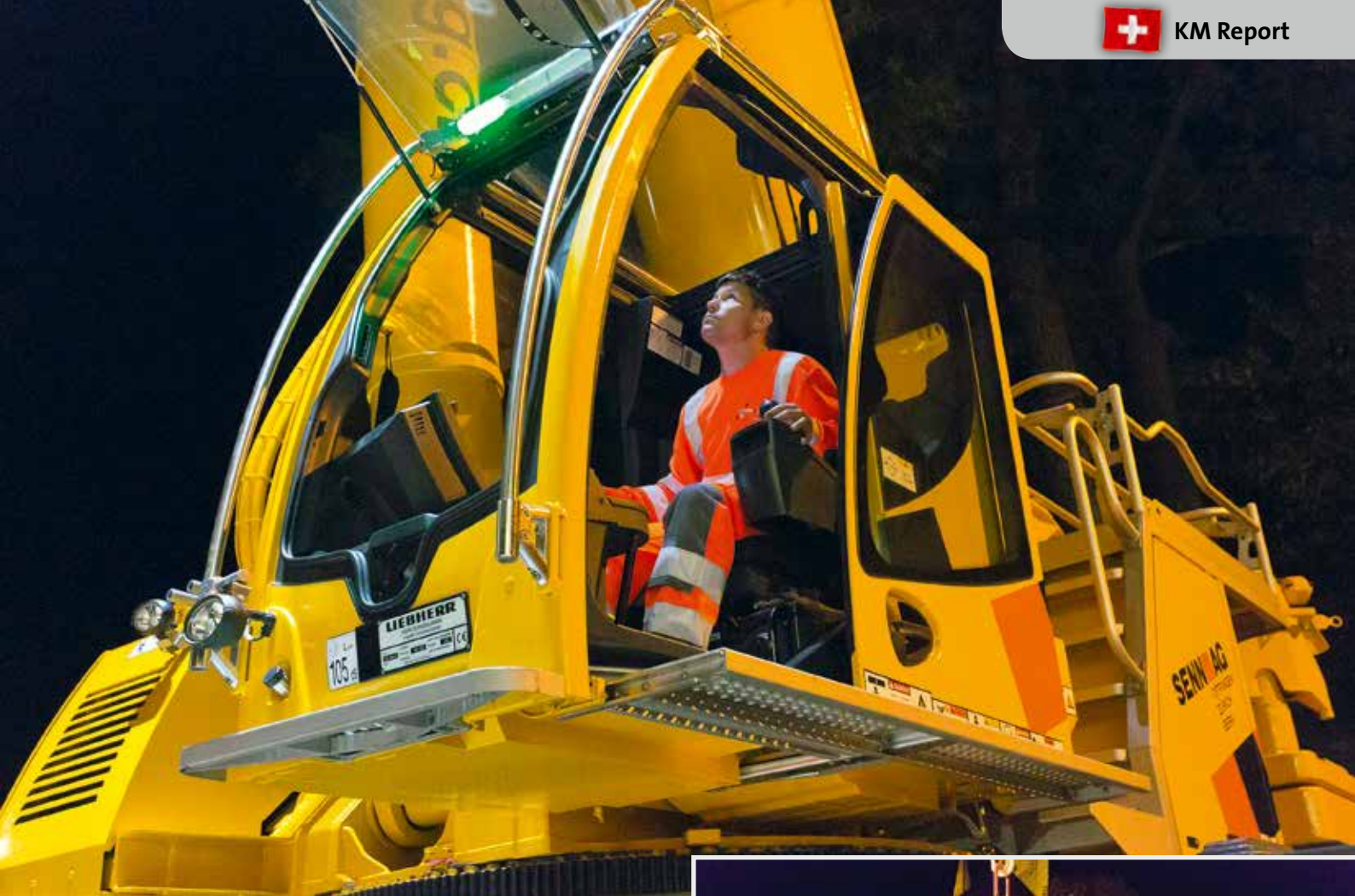
Hochkonzentriert: Peter Christen an den Steuerknüppeln beim Einheben der neuen Aarebrücke folgt den Anweisungen der Monteure.
