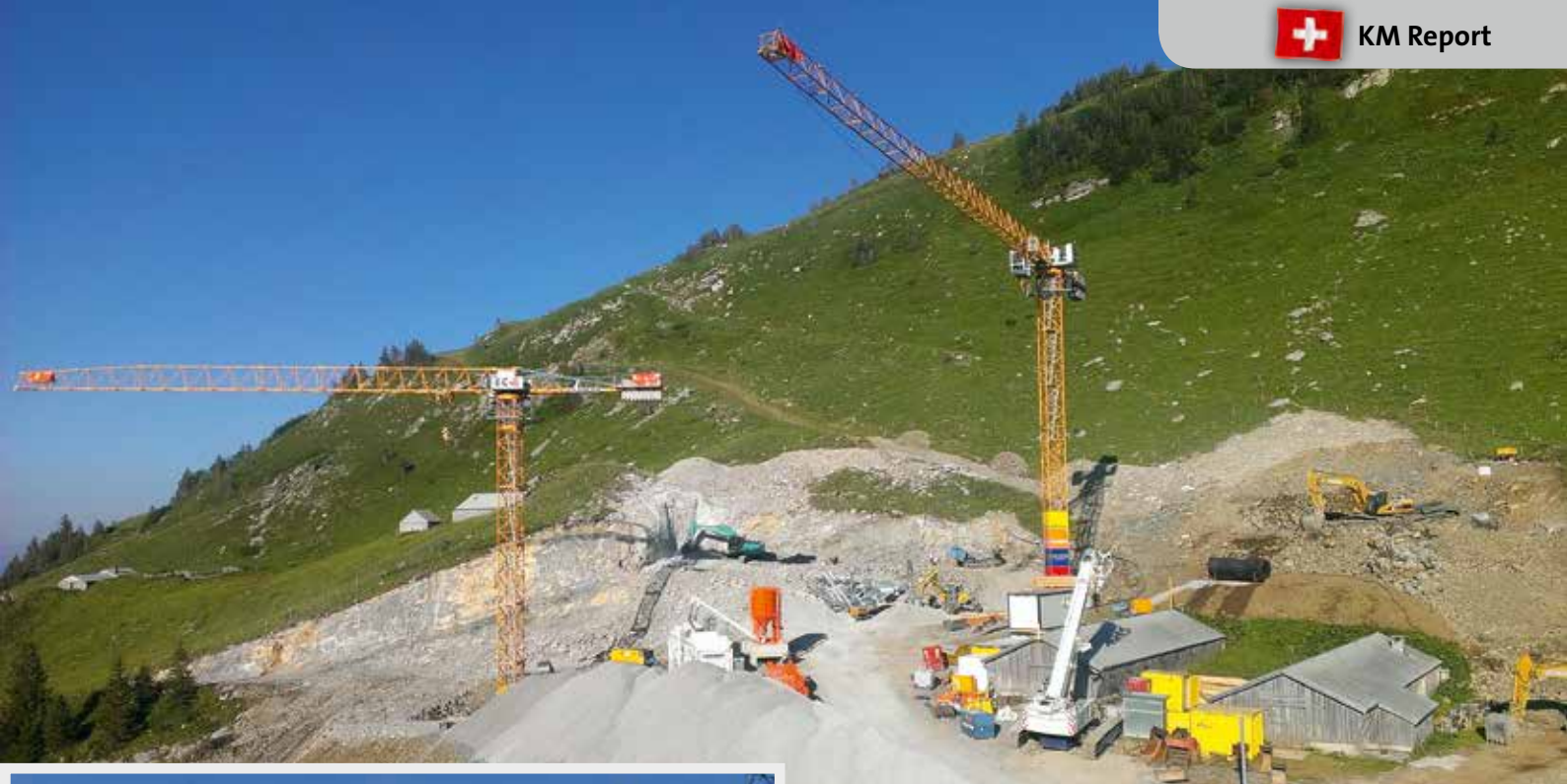
Nach der Turmdrehkranmontage übernahm der LTR 1060 noch weitere Hübe auf der Baustelle.
