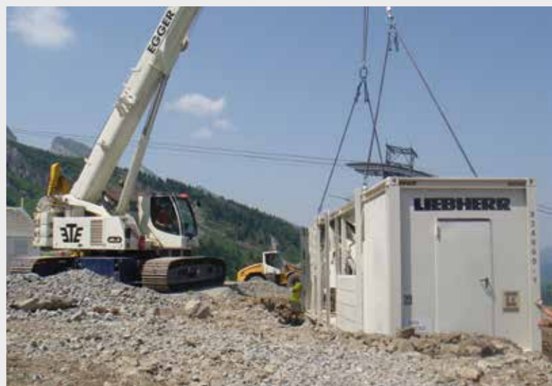
Nach der Turmdrehkranmontage übernahm der LTR 1060 noch weitere Hübe auf der Baustelle.
