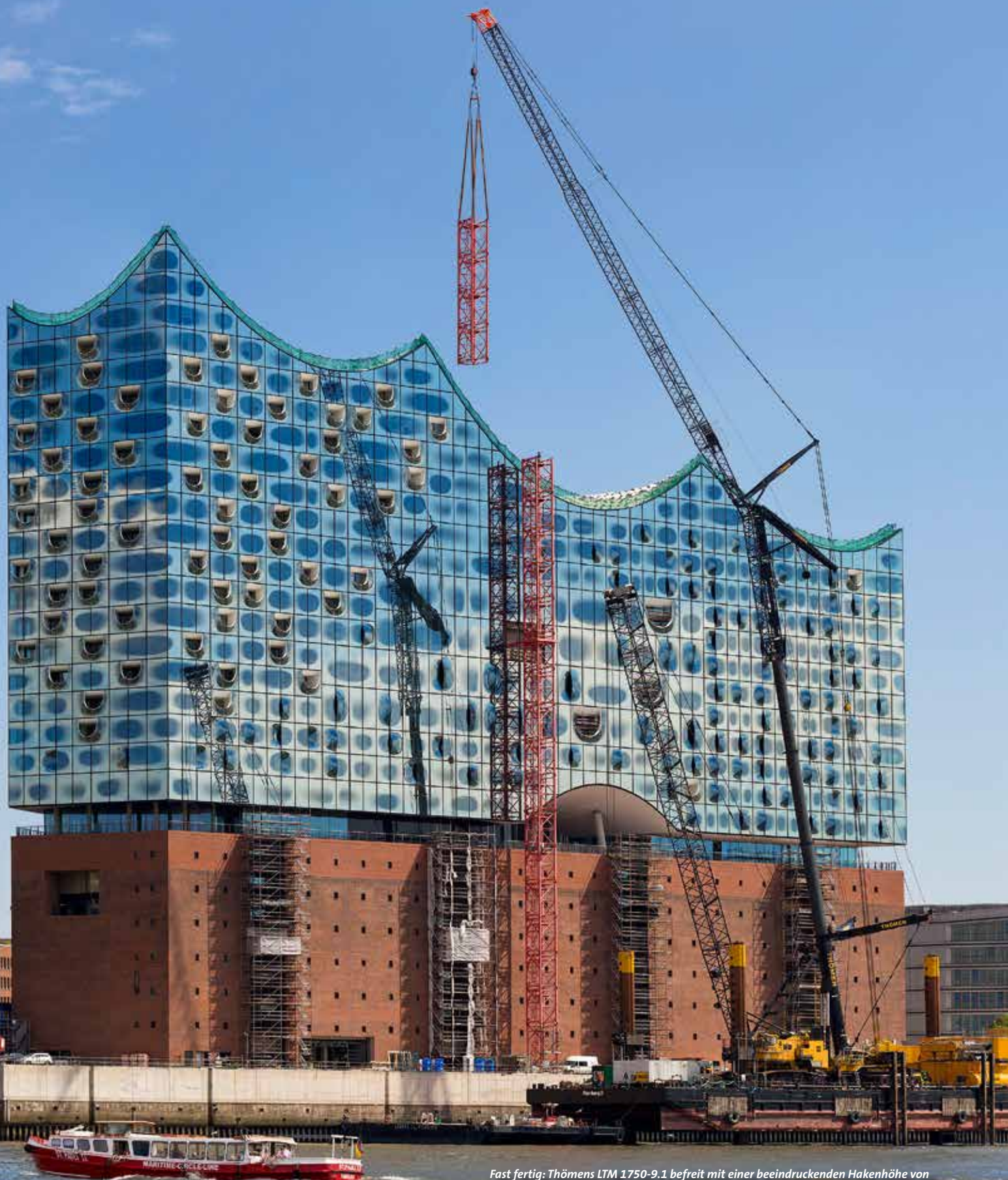
Fast fertig: Thömsen LTM 1750-9.1 befreit mit einer beeindruckenden Hakenhöhe von 127 m die Elbphilharmonie im Hamburger Hafen vom letzten Baukran.
