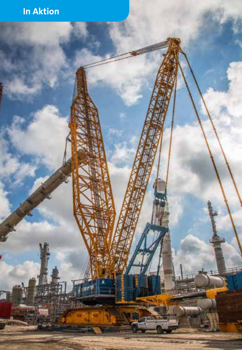
Schritt für Schritt wird die Kolonne gedreht und der Montagestelle angenähert.
