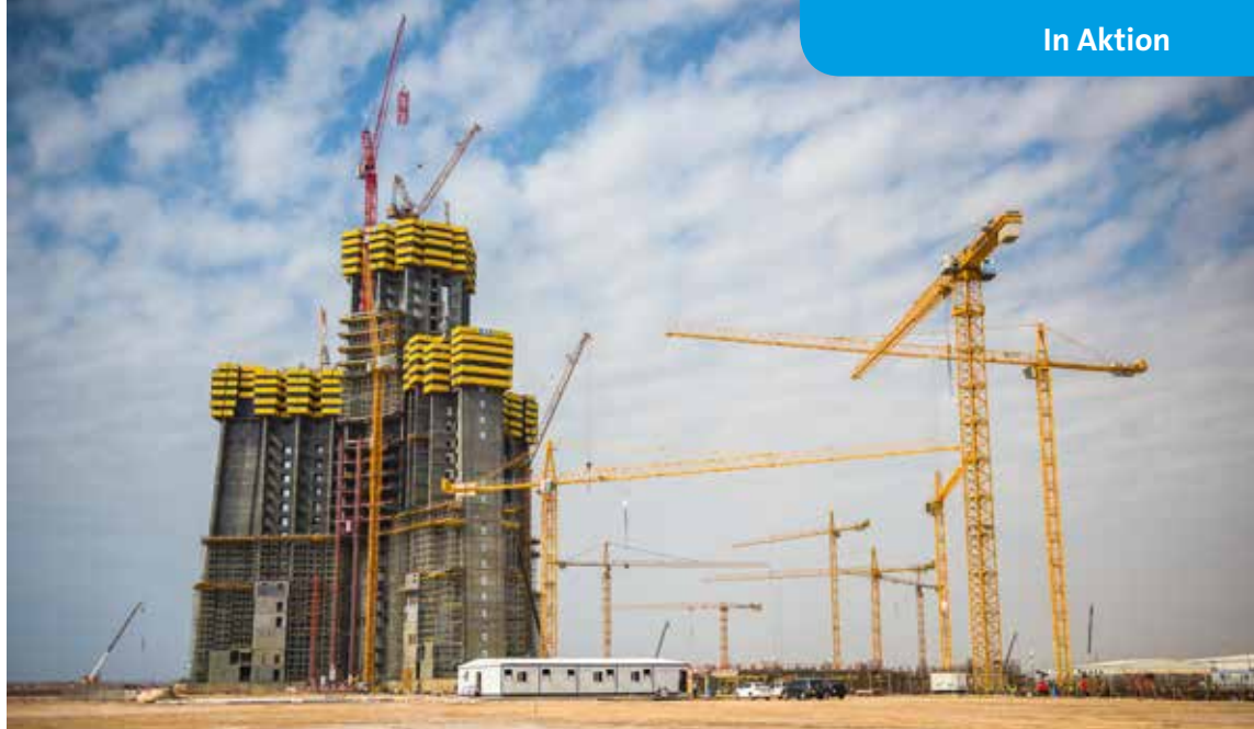
Der Jeddah Tower wird auf 270 Pfählen errichtet, die zwischen 45 und 110 m in die Tiefe reichen und einen Durchmesser von 1,5 bis 1,8 m haben. In einer Höhe von 630 m soll eine der höchsten Aussichtsplattformen weltweit installiert werden.
