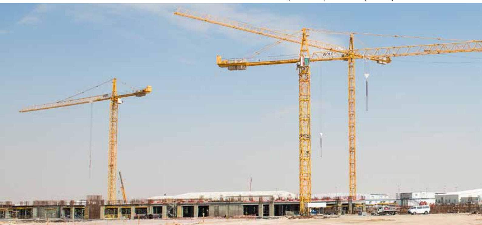
Neben Wippnern sind zwölf Wolff 7532 im Einsatz – hauptsächlich zur Lastenbewegung am Boden und für den Bau des Podiums am Fuß des Turms.
