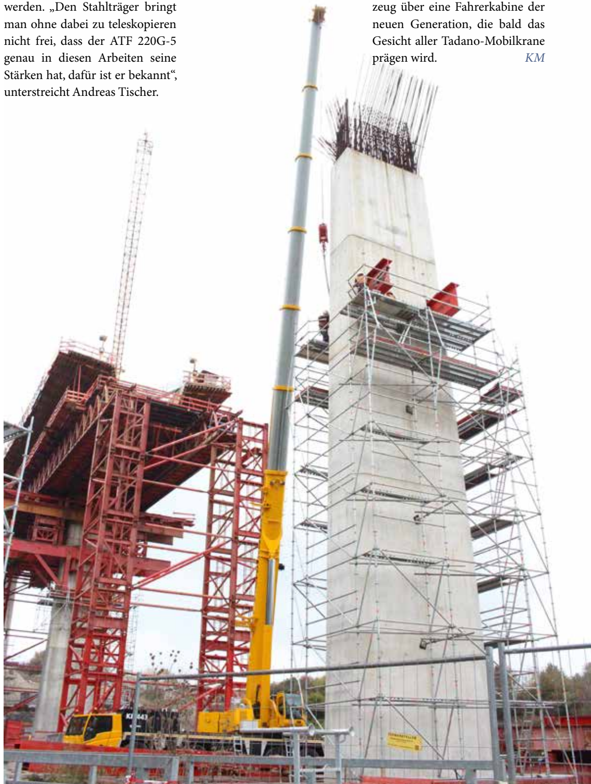
Schmidbauer setzte den Tadano ATF 220G-5 bei Brückenarbeiten ein. Dabei musste der Kran unter anderem bei einem Radius von knapp 18 m 22,5 t schwere Stahlgerüstteile einheben.
