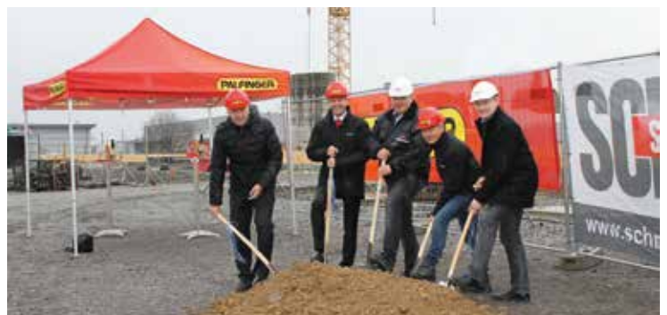
Spatenstich im Gewerbegebiet Bustadt in Ilsfeld (v.l.): Bürgermeister Thomas Knödler, Palfinger-Geschäftsführer Norbert Karrer, Norbert Bauer (Bauunternehmen Wildermuth), Niederlassungsleiter Uwe Falk und Markus Baier (Bauunternehmen Schmid).
