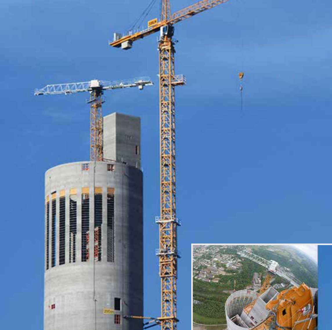
Zwei Liebherr-Turmdrehkrane beim Bau des Aufzugsturms in Rottweil.
