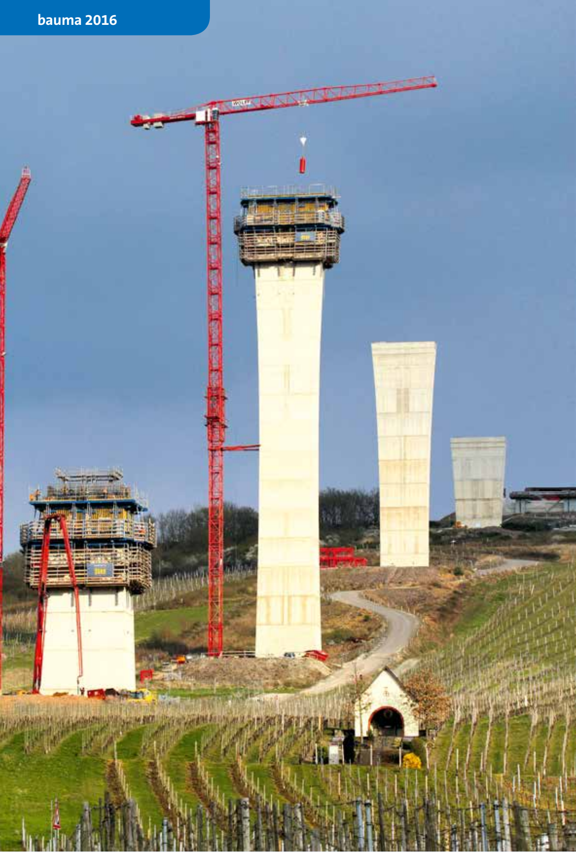
Am Bau der Hochmoselbrücke sind auch spitzenlose Turmdrehkrane von Wolffkran beteiligt. Im Bild ist der Wolff 6031 clear zu sehen. Auf der bauma stellt Wolffkran den Wolff 7534 clear vor, der die Reihe der spitzenlosen Krane nach oben hin abrundet.
