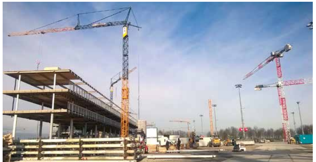
Der Liebherr-Stand im „Rohbau“.
