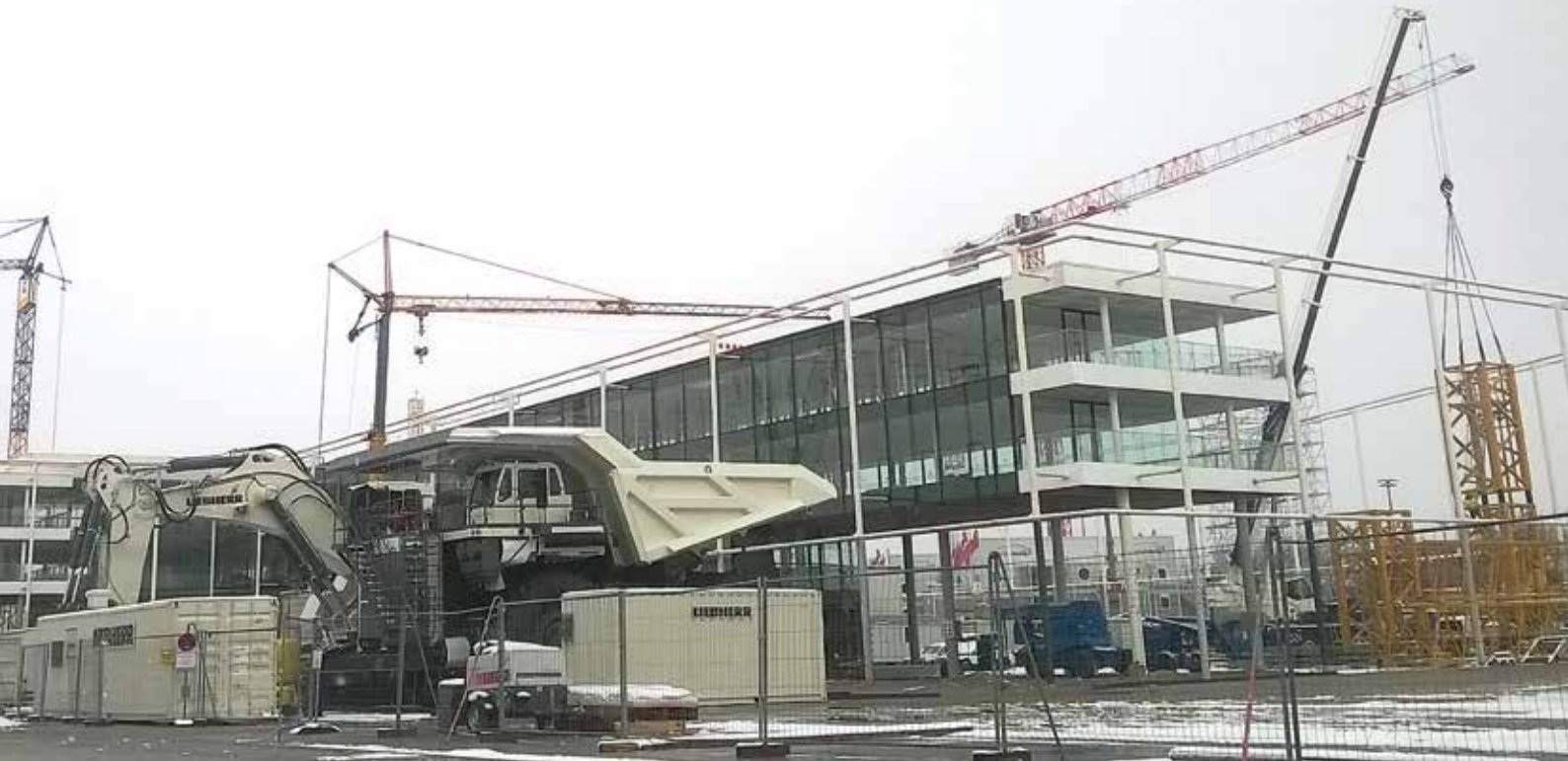
Schon vor Monaten haben die Aufbauarbeiten zur bauma 2016 begonnen.
