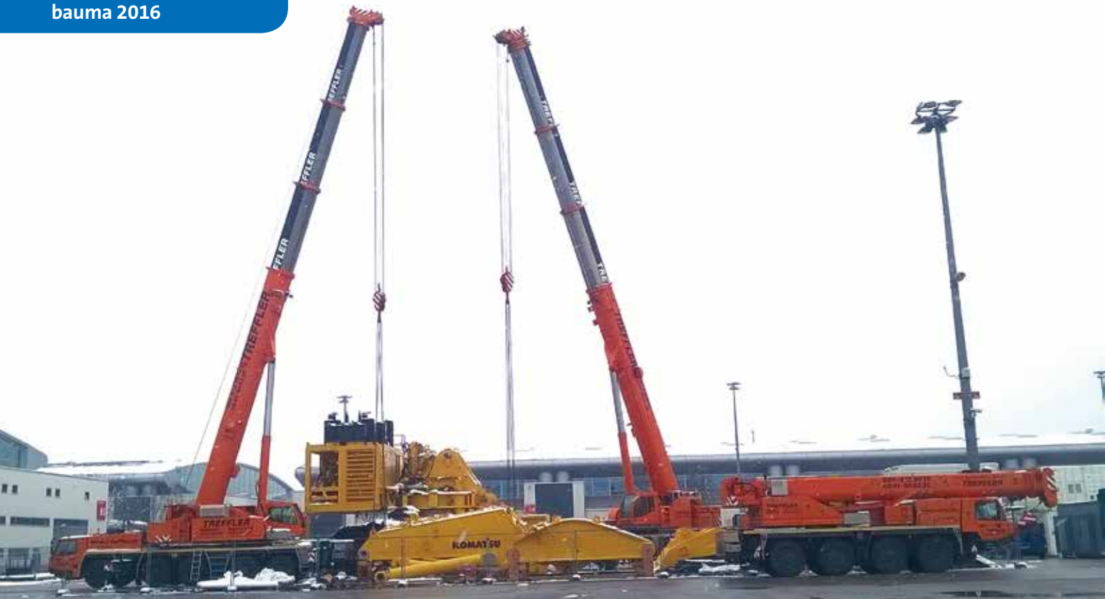
Anlieferung und Montage eines Komatsu-Baggers.
