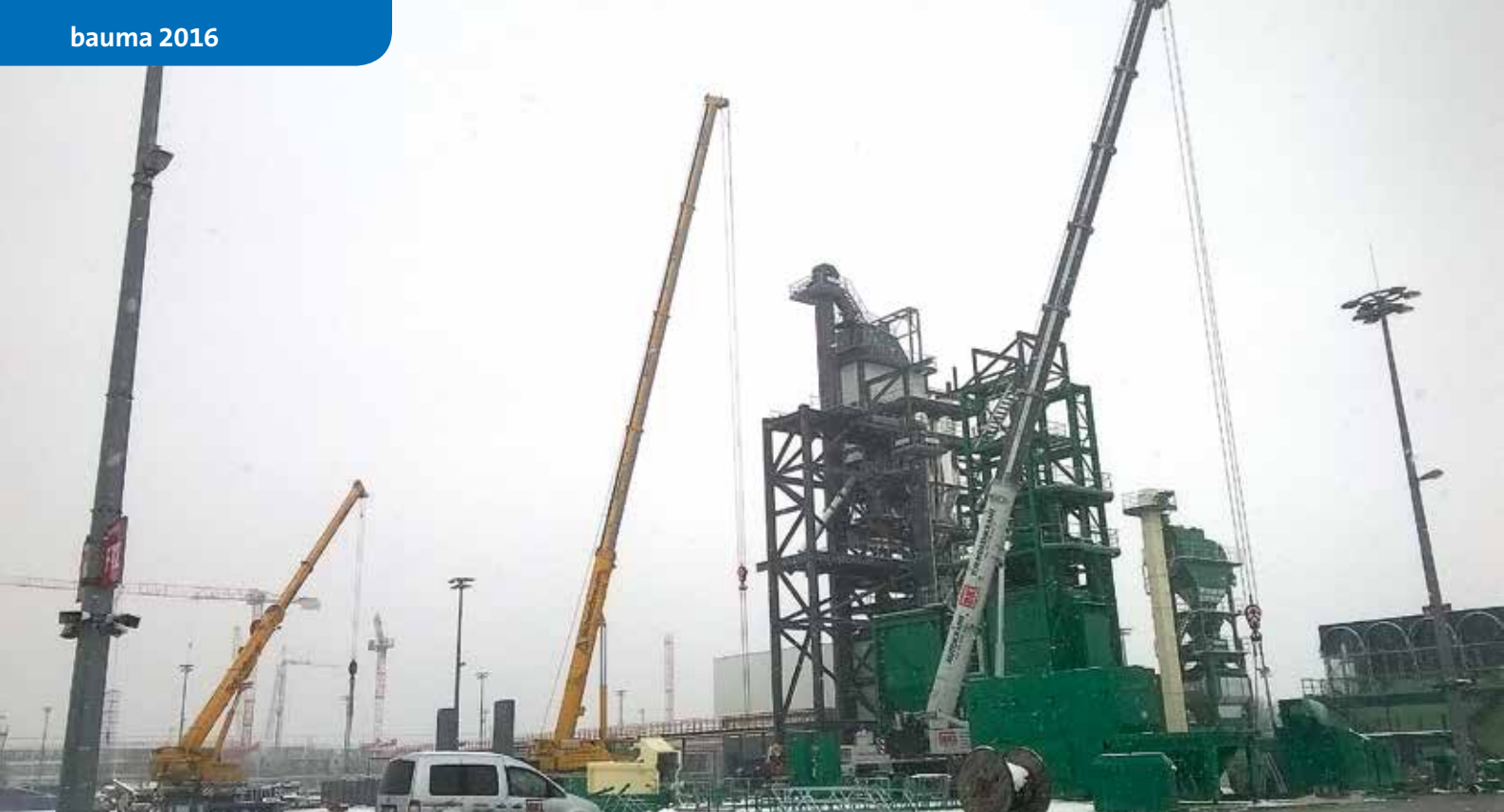
Auch das gehört zur bauma: Zementanlagen als Exponate – hier im Aufbau.
