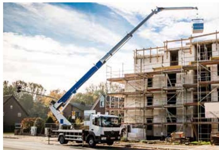
AK 37/4000 im Einsatz. Bei der Bedienung setzt Böcker auf eine SPS-Steuerung, die unter anderem auch eine Autonivellierfunktion der Stützen beim Aufbau des Krans beinhaltet.
