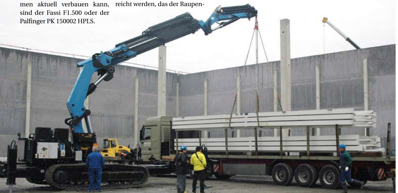
Dank Raupenfahrwerk begnügt sich der Kran mit wenig Platz. Zudem lässt er sich auf der Baustelle äußerst flexibel einsetzen.
