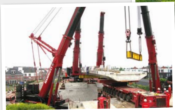
Die beiden hinteren Krane sind schon hubfertig, vorne wird gleich der gelbe Tragbalken unter die Brücke geschwenkt. Während des Hubvorgangs lagert die Brücke auf diesen Balken.
