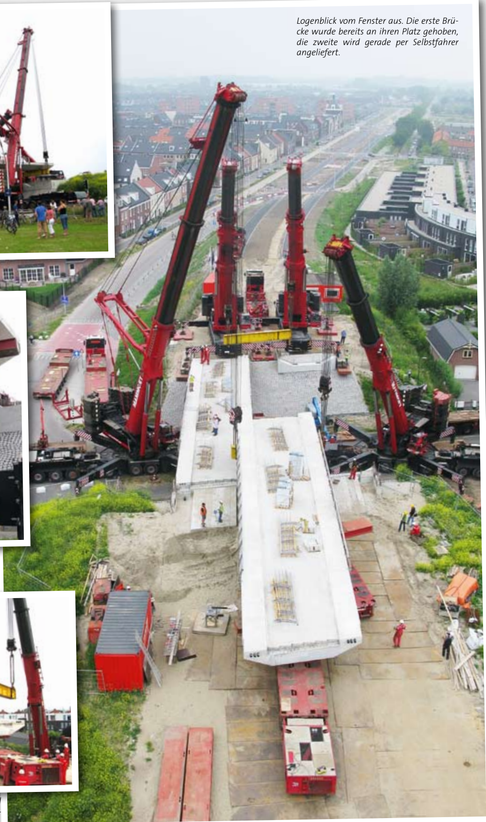
Die beiden hinteren Krane sind schon hubfertig, vorne wird gleich der gelbe Tragbalken unter die Brücke geschwenkt. Während des Hubvorgangs lagert die Brücke auf diesen Balken.
