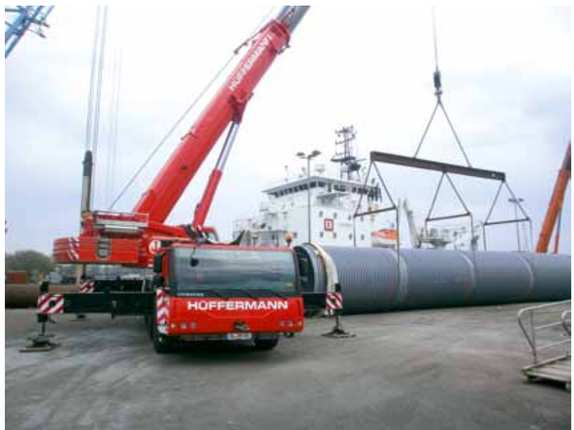
Hüffermann Krandienst hat sein Dienstleistungsangebot deutlich erweitert.
