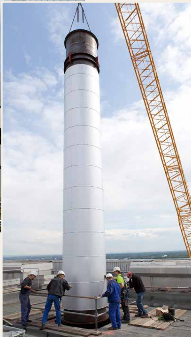
Team- und Millimeter-Arbeit über Funk: eines der kleineren Schlot-Teile wird durch das Dach in das Kraftwerksgebäude eingehoben.
