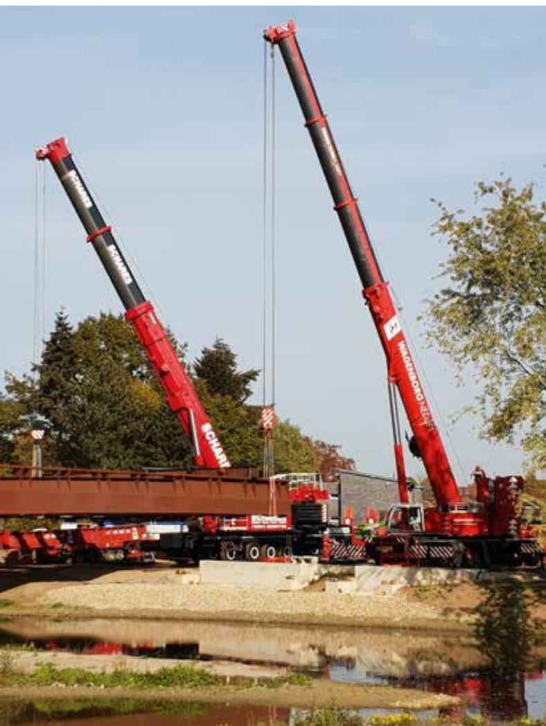
Am Nordufer nahmen der LTM 1500-8.1 von Schares und der ATF 400G-6 von Wagenborg die Brücke an die Haken ...
