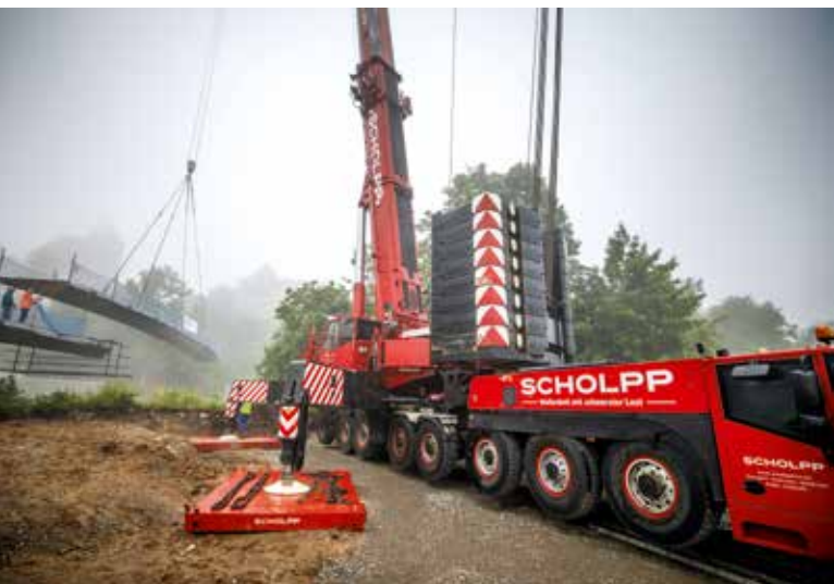
Mit 36 m Wippe kam der AC 500 zum Einsatz.
