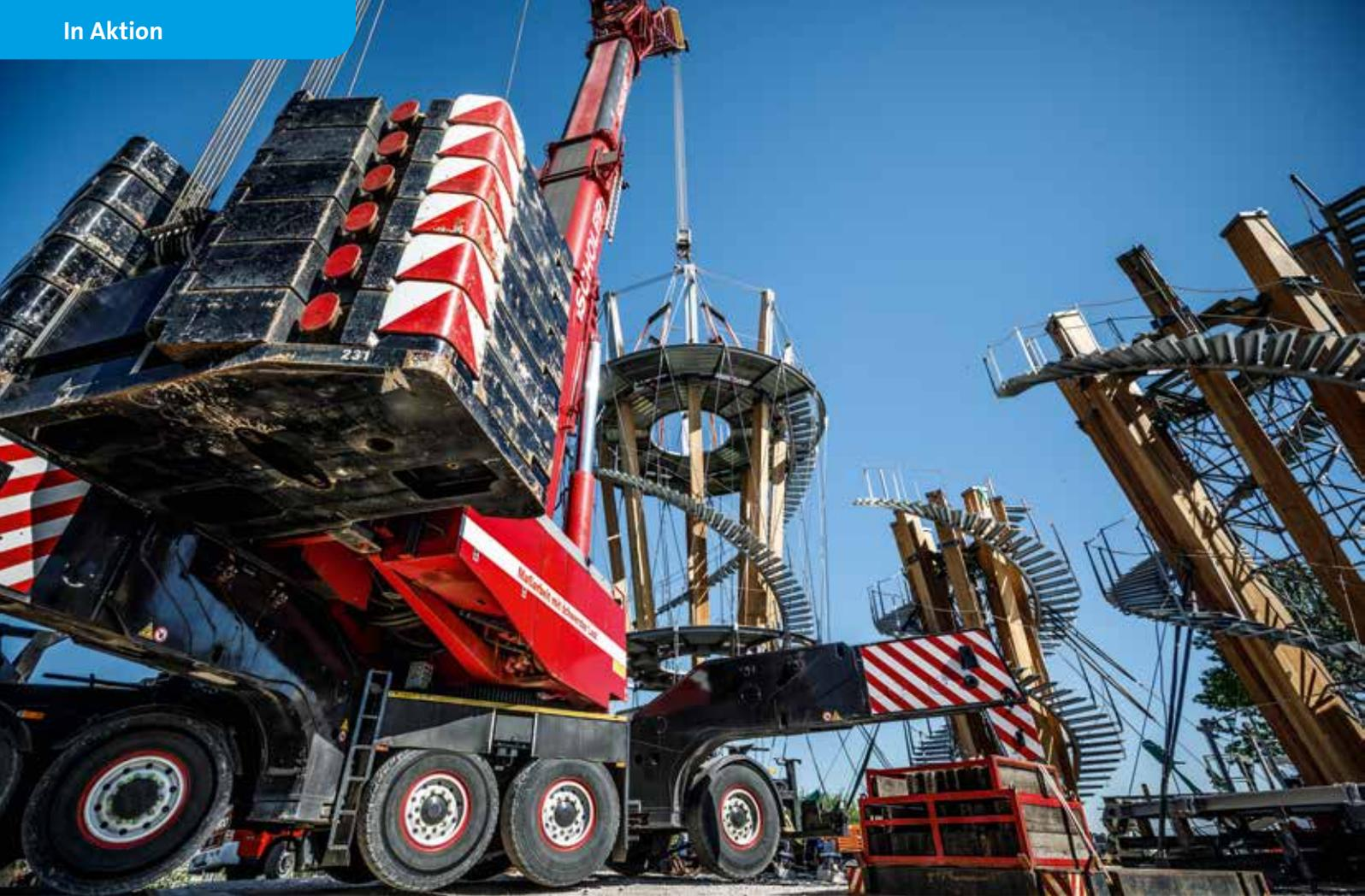
Mit insgesamt 180 t Ballast kam der 500-Tonner zum Einsatz.
