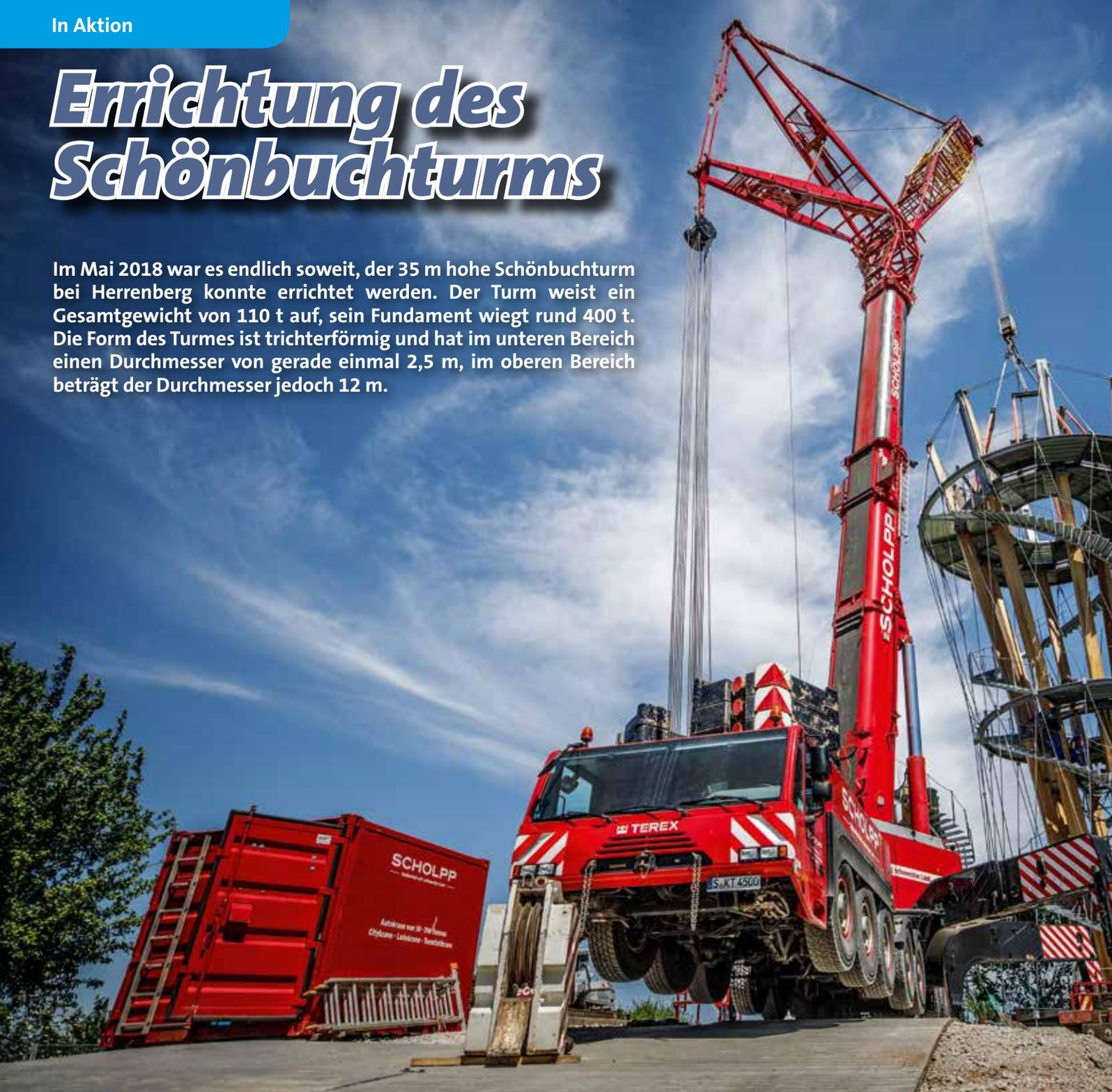
Für die Montage der drei Segmente kam der S-GK 500 (Anm. d. Red.: Scholpp-interne Bezeichnung für den AC 500-8) mit 24 m Wippe und 180 t Ballast zum Einsatz. Nach einem Blick in die Tragkrafttabelle war klar: Der Kran musste so zur Last und dem Montageort platziert werden, dass beim Einheben der drei Segmente eine Ausladung von 15 m nicht überschritten und gleichzeitig eine Ausladung von 14,30 m nicht unterschritten wurde.
