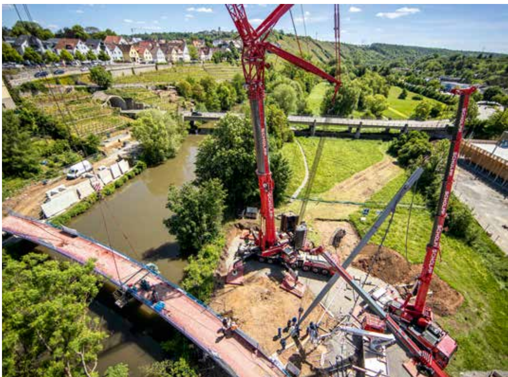
Kran-Trio unterstützt den Bau des Mühlenstegs.
