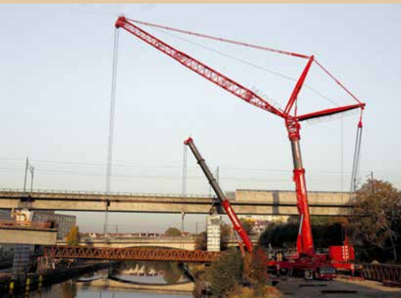
... wurde ein Schwimmkraneinsatz überflüssig gemacht.
