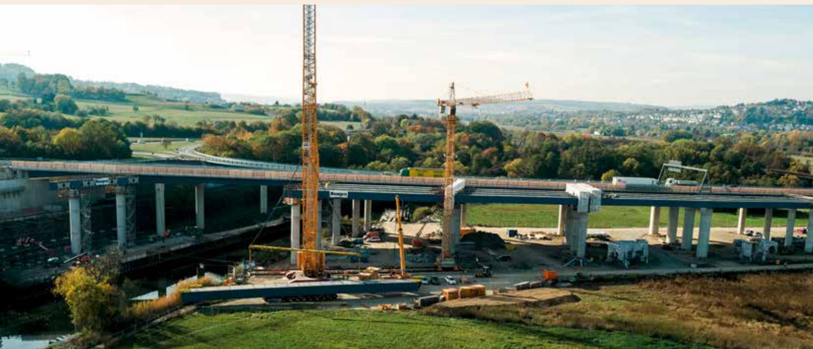
Nachdem ein Längsträger eingehoben worden ist, wird der nächste Träger vom Vormontageplatz per Selbstfahrer zum Kran gefahren.
