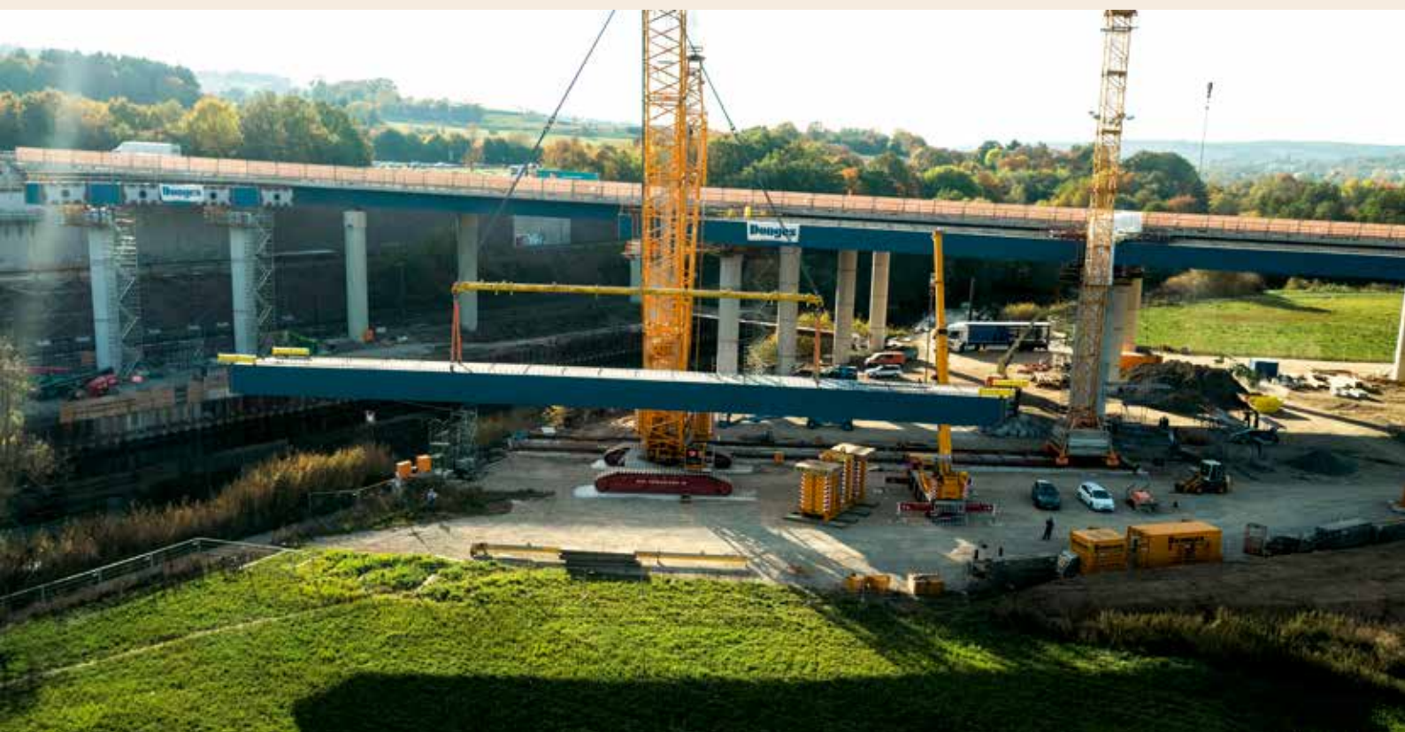
... wurden über Rundschlingen an einer Traverse angehängt.
