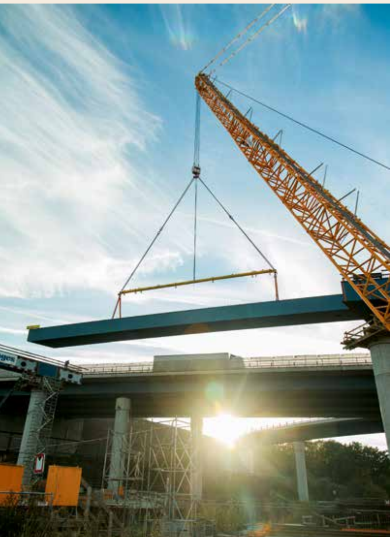
Nachdem der Superlift-Ballast angehängt worden ist ...
