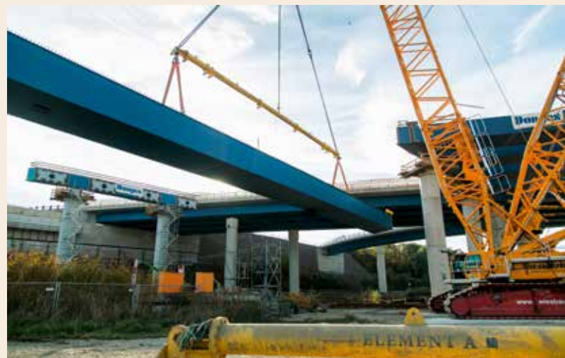
... kann der Kran auf Ausladung gehen.
