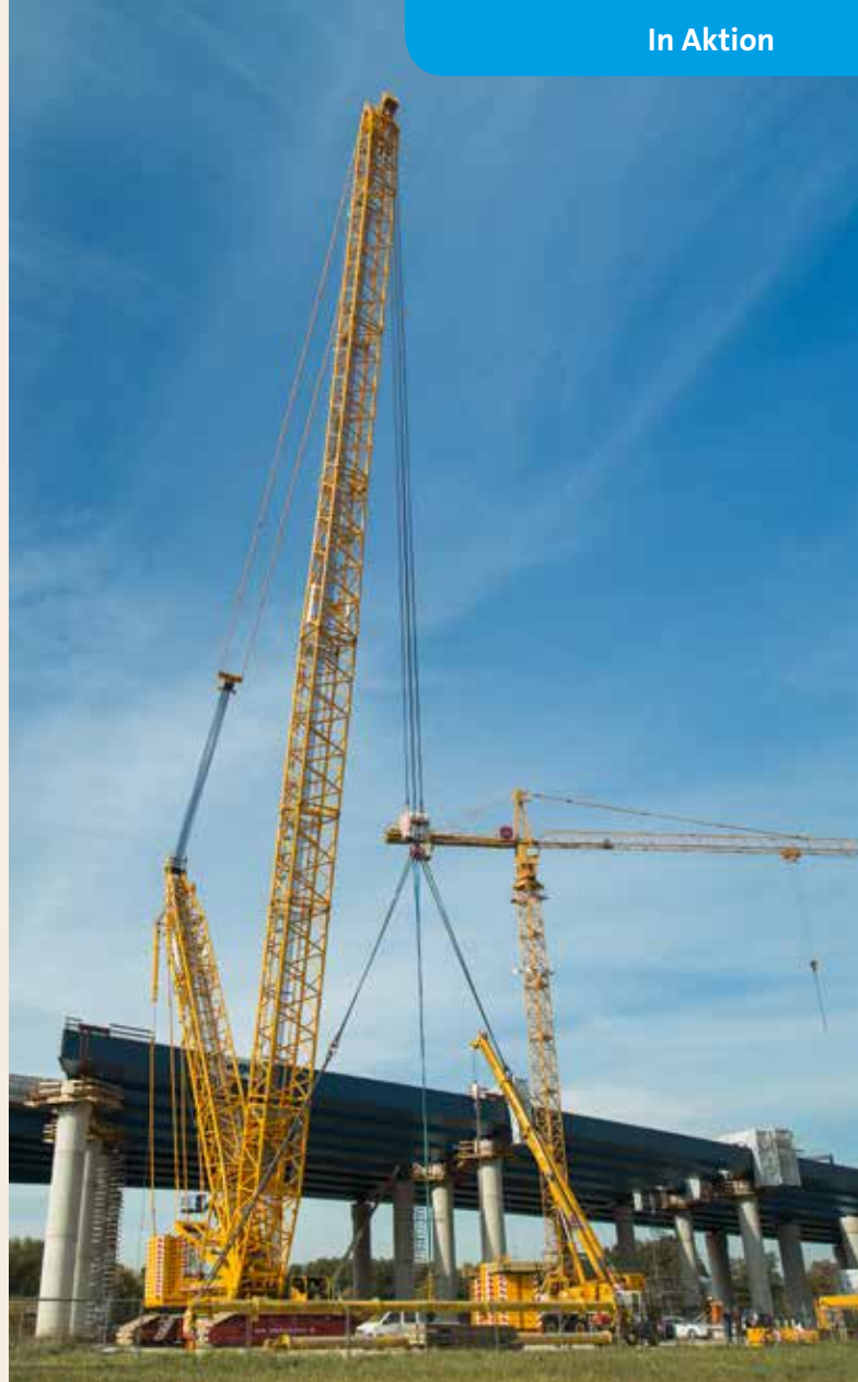
Die bis zu 54 m langen Stahlträger ...
