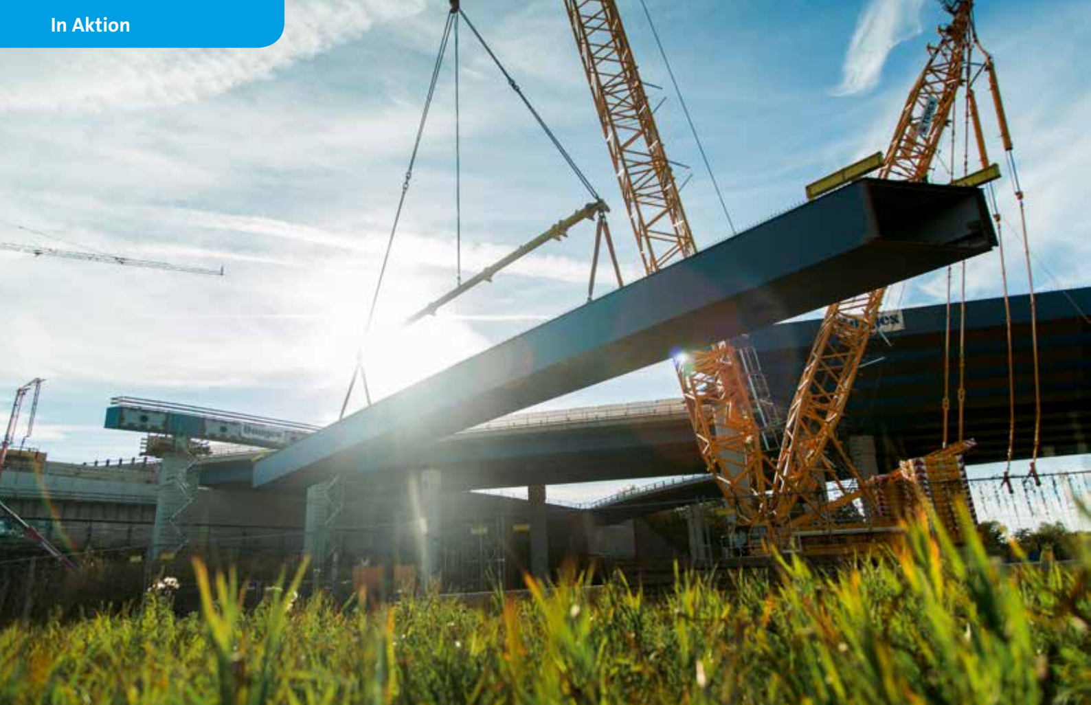
Nach dem Anschlagen und Anheben der Last schwenkt der Kran zunächst ohne Superlift-Ballast bis in die Superlift-Ballast-Position.
