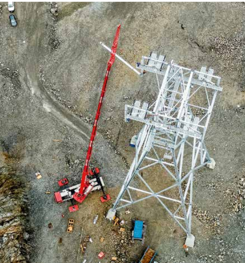
Die beiden Stützen der Seilbahn sind jeweils 60 m hoch.
