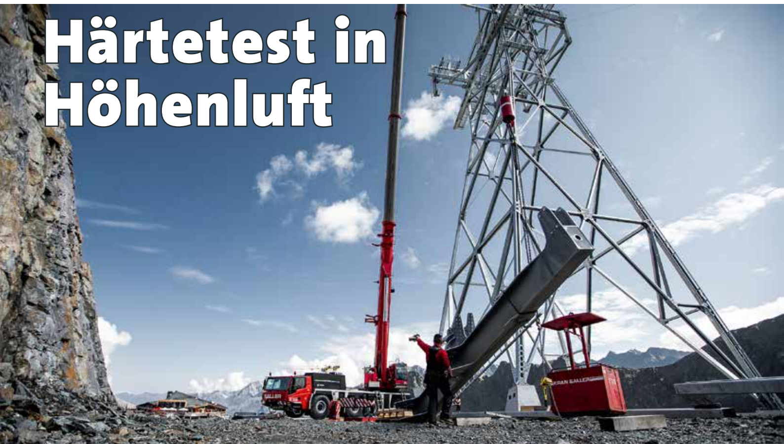
Der ATF 200G-5 auf 2.750 m Höhe beim Aufnehmen eines Stahlbauteils.
