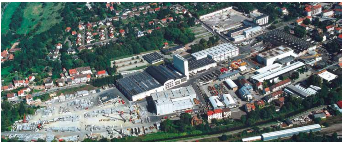
Blick auf das Tadano Demag-Werk in Zweibrücken.
