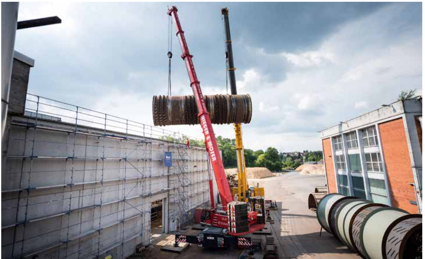
Ein LTM 1350-6.1 von Rieger & Moser und ein LTM 1400-7.1 von Fricke-Schmidbauer arbeiten in Ehingen beim Austausch einer Entrindungstrommel zusammen.
