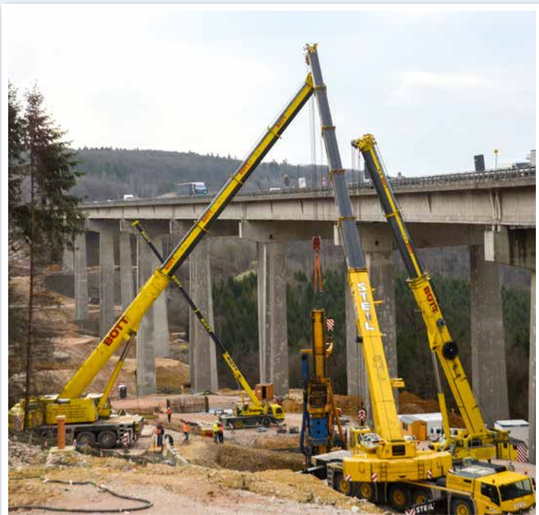
Dank des gemeinsamen Einsatzes von AC 350, GMK6300 und ATF 220G-5 kann das nach hinten umgekippte Bohrgerät wieder auf seine Raupen gestellt werden.
