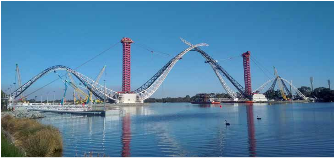
Montage der Matagarup-Brücke im australischen Perth. Die beiden roten Mega Jacks von ALE fungieren dabei als vorübergehende 50 m-Türme.
