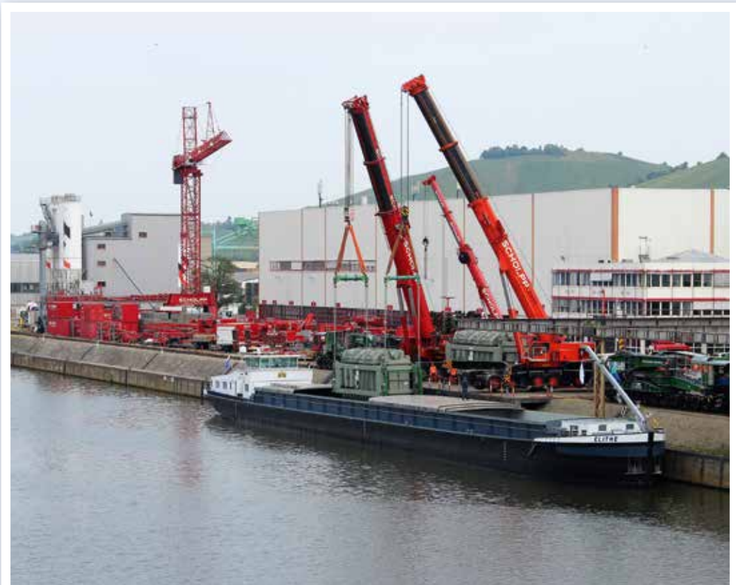
Für den Hub der 12 m langen, 5 m hohen und knapp 3 m breiten Transformatoren kommen die Schlopp-Krane S-GK 700 mit 160 t Ballast und Zentralabstützung, 25,5 m Mastlänge und 12 m Ausladung, sowie der S-GK 500 mit 160 t Ballast, 24 m Mastlänge bei einer Ausladung von 10 m im Tandemhub, zum Einsatz. Der S-HK 70 unterstützt die zwei Großkrane beim Anbau der Hebeschwerter an die Trafos.
