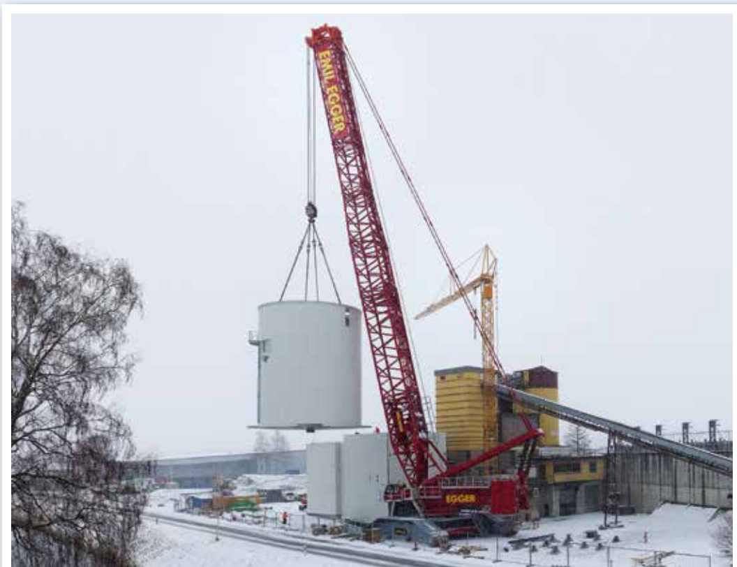
Im schweizerischen Oberriet muss der Liebherr LR 11000 einer Bruttolast von 140 t bei maximal 16 m Ausladung stemmen.
