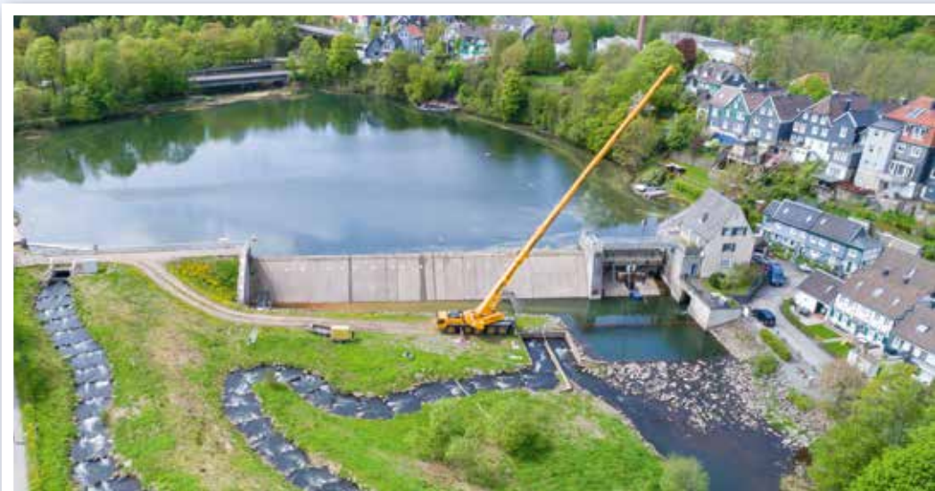
Einsatz am Bayernburger Stausee: Der zu tauschende Hubzylinder der Staumauer bringt rund 5 t auf die Waage.
