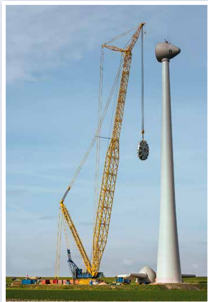
Demag CC 8800-1 im Einsatz mit Boom Booster.
