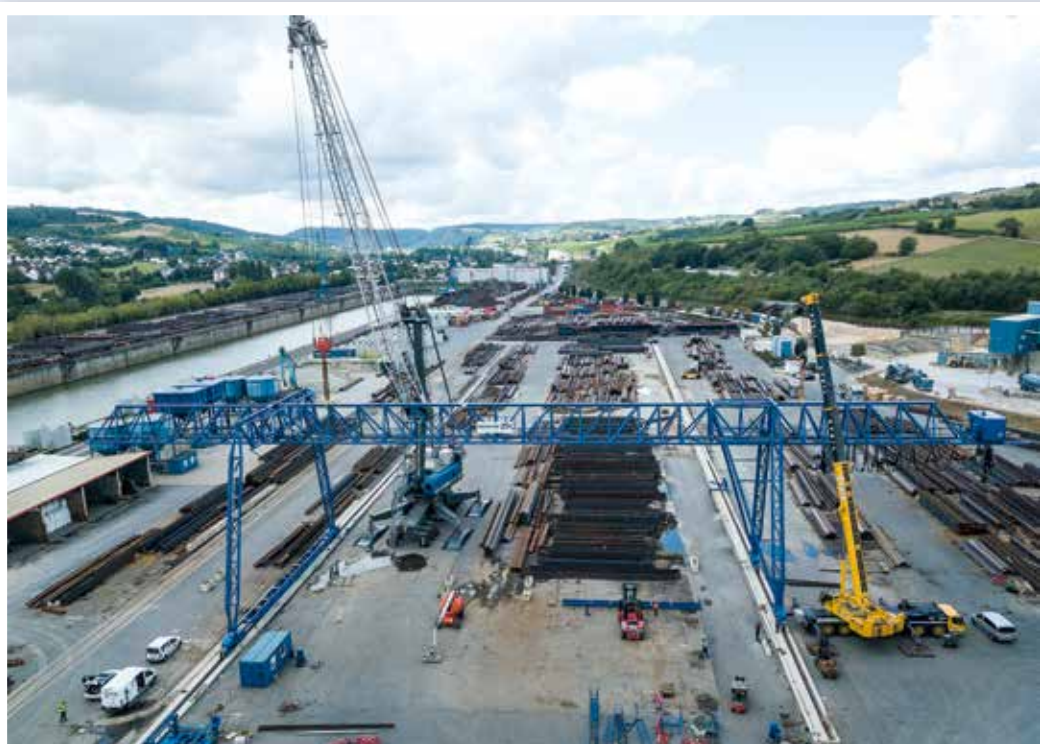
Montage des Zweischienen-Stahlrohr-Portalkran im einzigen Binnenhafen Luxemburgs.
