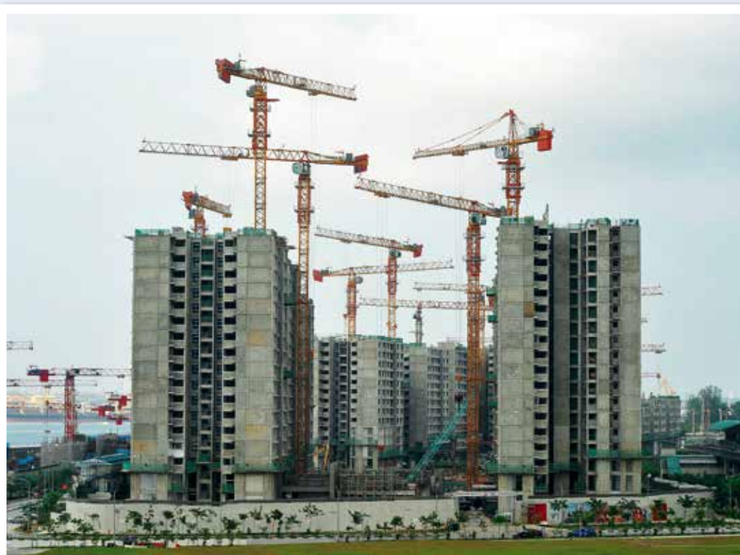
Bei diesem innovativen Wohnungsbauprojekt kommt gleich eine ganze Flotte von Potain-Turmdrehkränen zum Einsatz.
