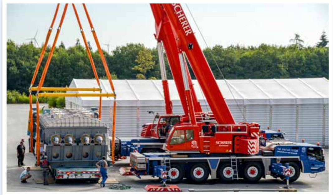
Mithilfe eines LTM 1200 und eines ATF 180G-5 wird der Trockner im Tandemhub auf einen Semitiefelader aufgeladen und anschließend punktgenau rückwärts in die Halle zwischen die Hubfahrbahnen manövriert.
