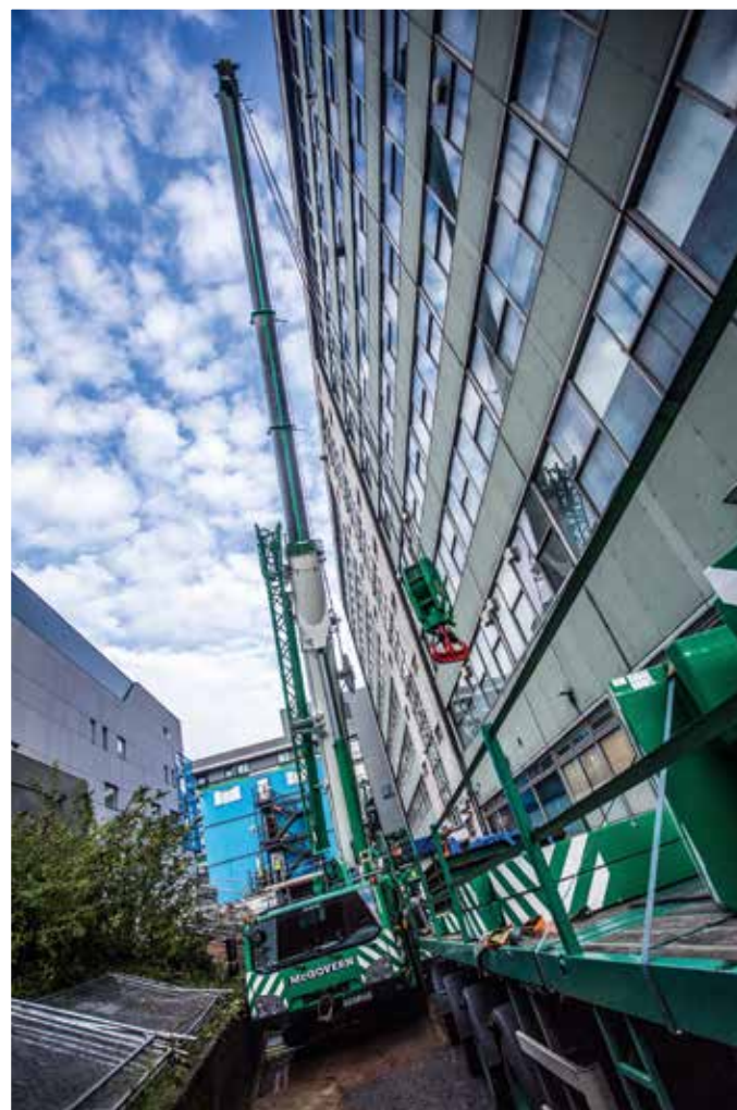
Der Demag AC 220-5 war kompakt genug für die Zufahrt.
