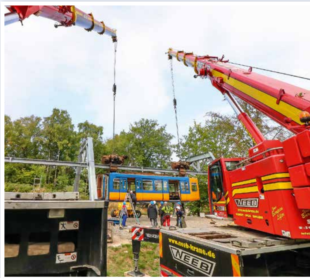
Tandemhub: Zwei Liebherr-Teleskopaufbaukrane LTF 1060-4.1 montieren die ausrangierte Schwebebahn an ein neues Hängegerüst. Foto: Michael Bergmann
