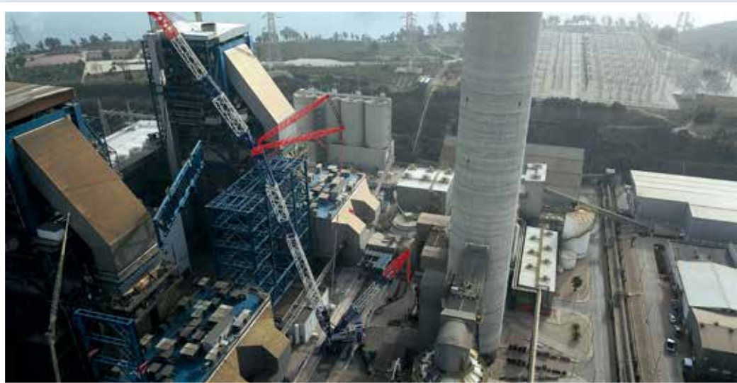
Auf bis zu 100 m Höhe hebt der CC 6800-1 die Stahlkonstruktionsteile.
