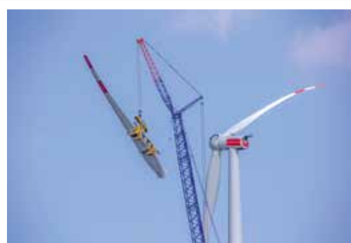
Das Single-Line-Guiding-System von Liebherr stabilisiert die Rotorblatt-Traverse mit Flügel im Wind.
