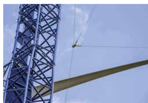
Die Seilrolle wird an einem vorgespannten Seil am Hauptausleger entlanggeführt.
