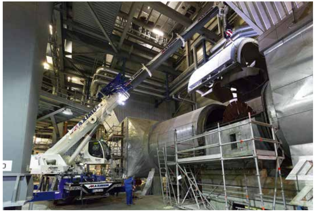
Platzmangel: Umgeben von Pfeilern und Anlagenteilen macht der Kompaktkran im Kraftwerk seinem Namen alle Ehre.
