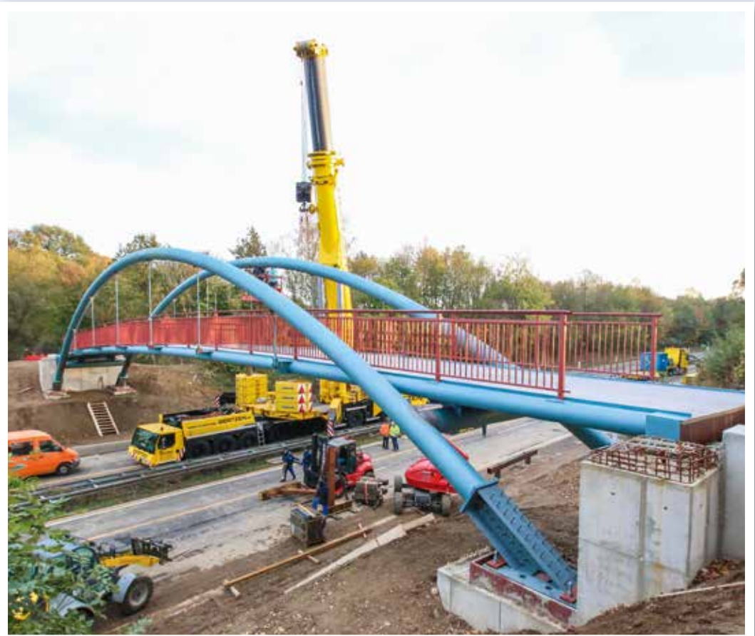
Auch KM-Mitarbeiter ist von der Umlegung des Montagetermins überrascht worden. Aber dieses Bild der gerade eingehobenen Brücke gelingt ihm dennoch. Bild: Michael Bergmann
