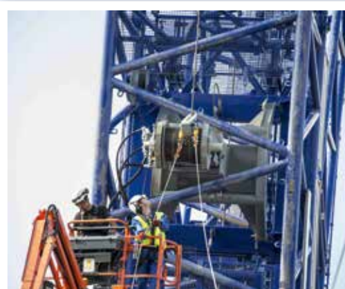
Die Montage der Traverse an das Single-Line-Guiding-System ist einfach.
