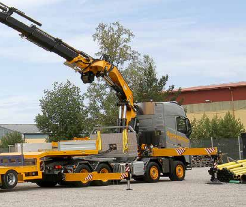
Bei der Erstmontage eines LTM 1350-6.1 gab es tatkräftige Unterstützung durch den Fassi F990.
