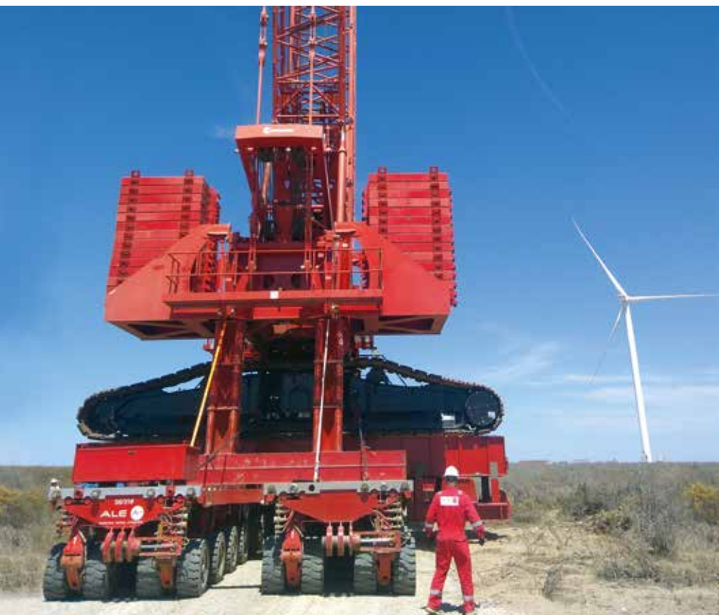
Windenergie als Exportschlager – ALE im Windparkeinsatz in Argentinien. Weil die Wege im Windpark teilweise sehr schmal waren, wurde der eingesetzte Raupenkran, ein Manitowoc 18000, auf SPMT zu den Einsatzorten bewegt.
