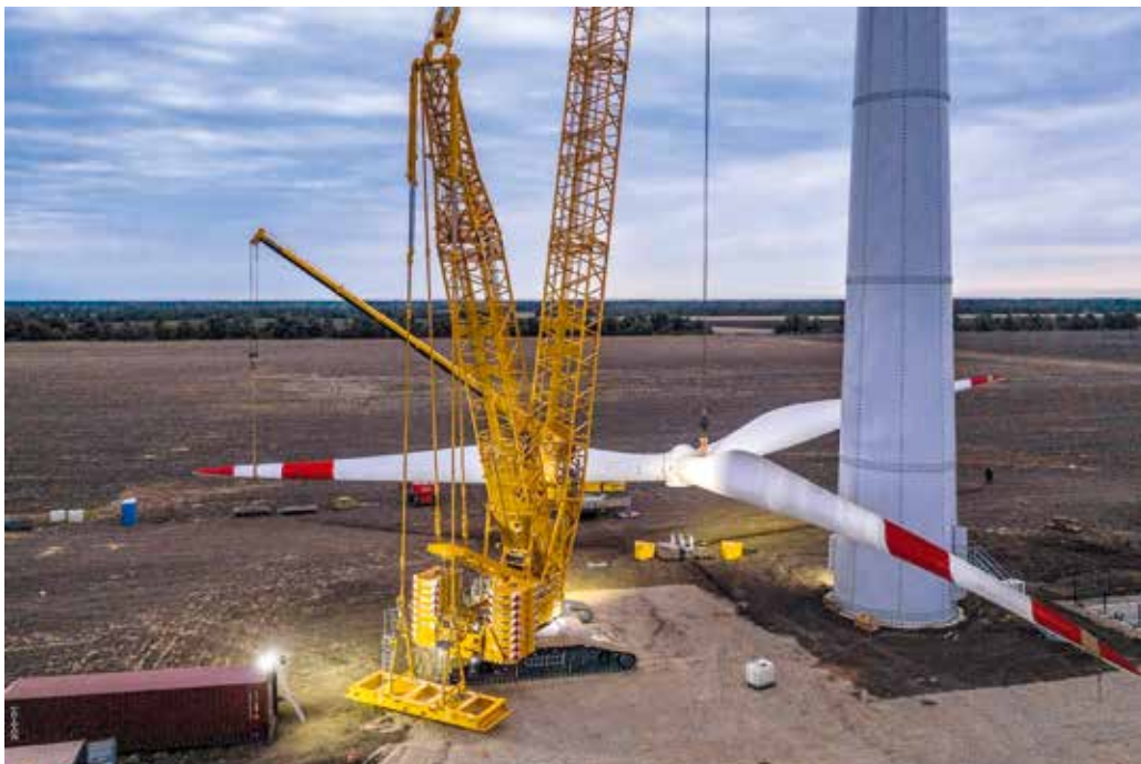
LR 1500 als Windkraftkran in Russland.
