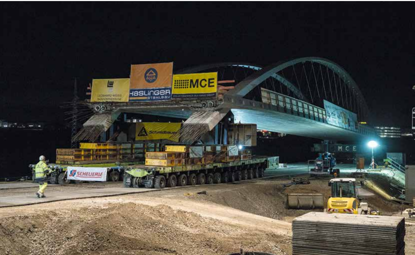
Auf insgesamt 56 SPMT Achslinien und 224 Reifen ruhte die 130 m lange Brücke. Insgesamt wog der Transport rund 2.000 t.
