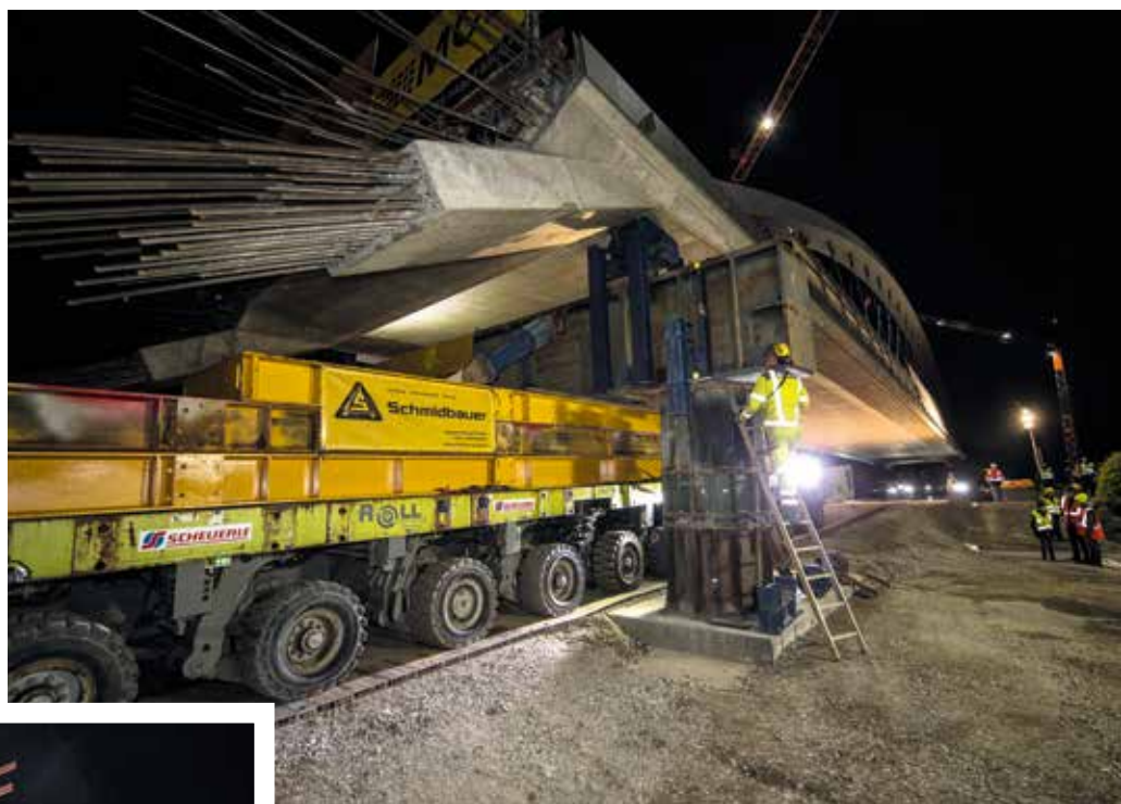
Aufsehenerregender Transport: Mit insgesamt vier SPMT Transportern beförderte Schmidbauer die 1.500 t schwere Brücke über die Autobahn an ihren Standort.
