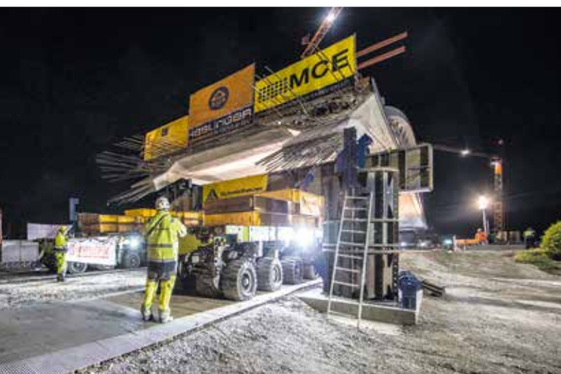
Aufsehenerregender Transport: Mit insgesamt vier SPMT Transportern beförderte Schmidbauer die 1.500 t schwere Brücke über die Autobahn an ihren Standort.
