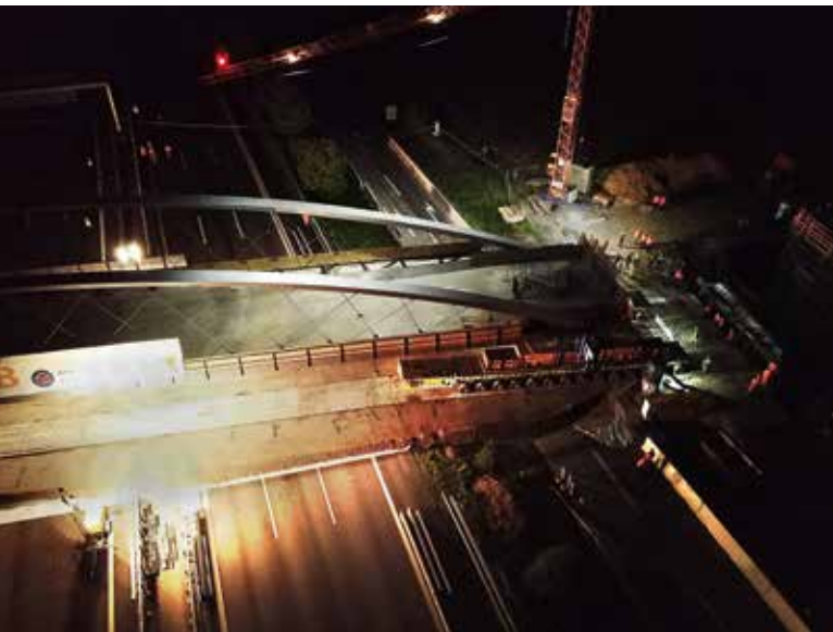
Für den Transport setzte Schmidbauer 8 x 4-Achs SPMT + 4 x 6-Achs SPMT + vier PPU Z390 und vier Fahrer ein.
