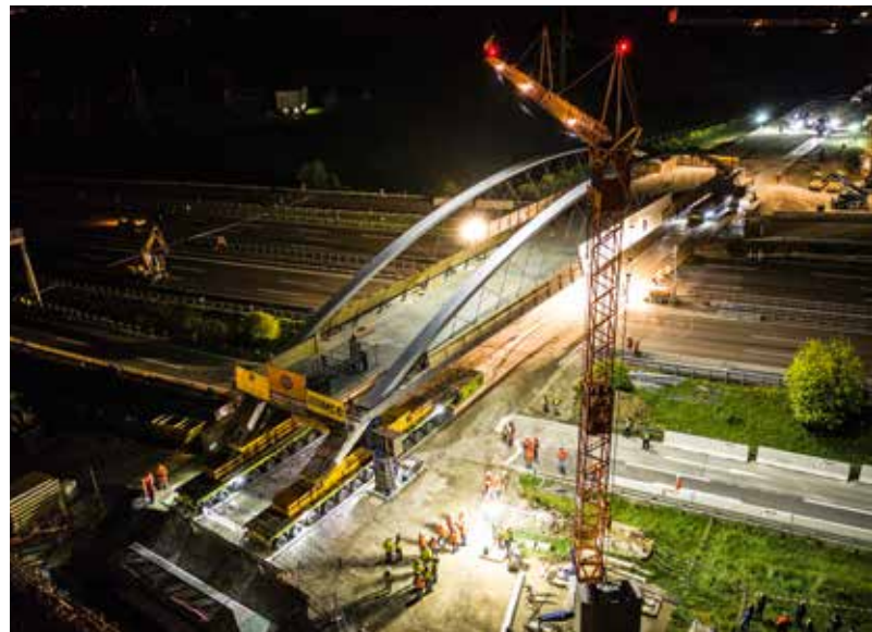
Für den Transport setzte Schmidbauer 8 x 4-Achs SPMT + 4 x 6-Achs SPMT + vier PPU Z390 und vier Fahrer ein.
