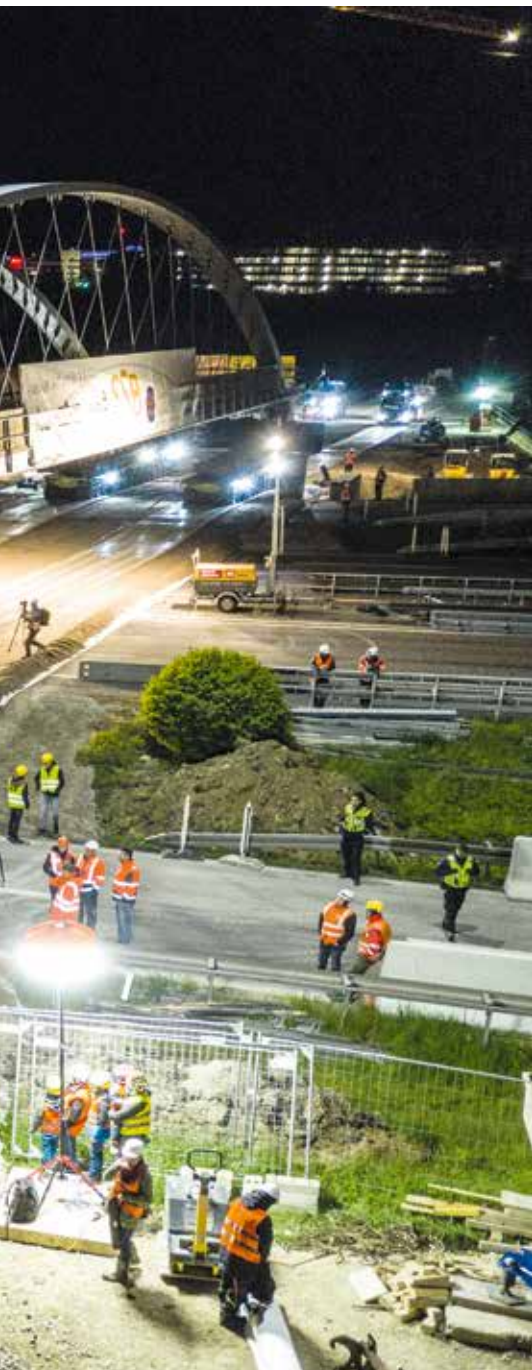
Aufsehenerregender Transport: Mit insgesamt vier SPMT Transportern beförderte Schmidbauer die 1.500 t schwere Brücke über die Autobahn an ihren Standort.
