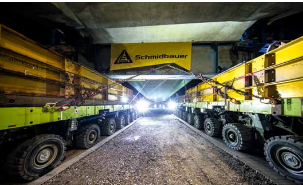
Mit wenigen Zentimetern Toleranz musste die Brücke auf den Stützfeilern abgesetzt werden.
